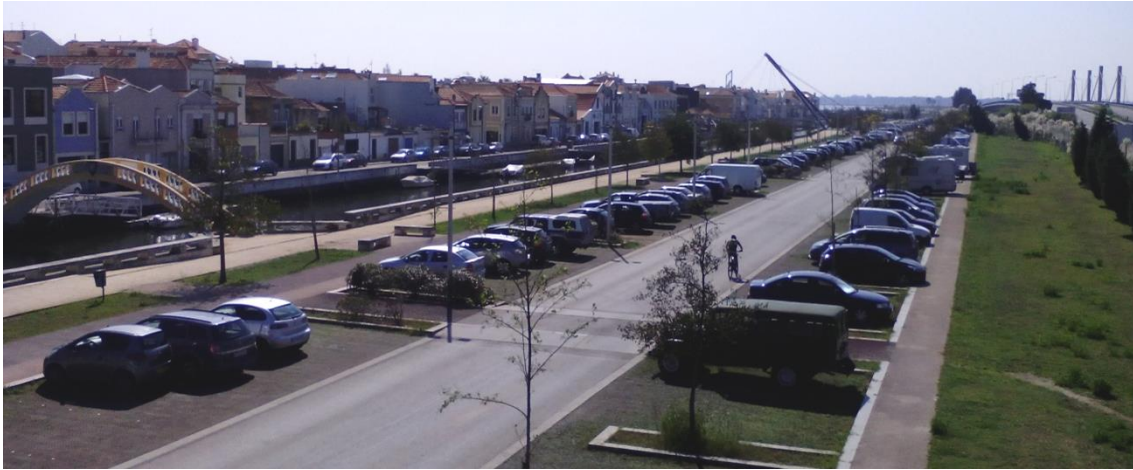
Fig.44 | Margem norte do canal de S.Roque com a Ponte de Carcavelos (à esquerda), a Ponte dos Botirões (ao fundo) e a A25 (à direita)
