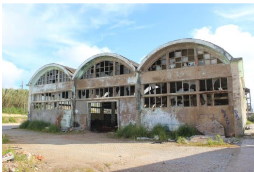
Fig.33 | Fábrica Vitasal_alçado nascente (2014)
