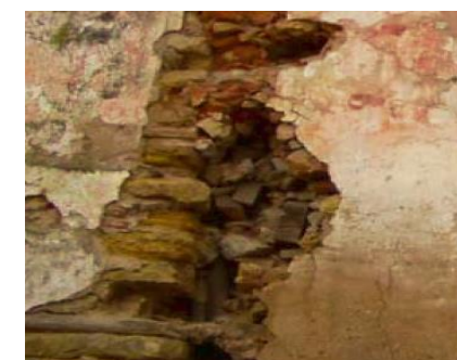
41 | Parede de alvenaria de pedra de um edifício em Coimbra. Fonte: Vicente, R. - Estratégias e met. para intervenções de reabilitação urbana.
