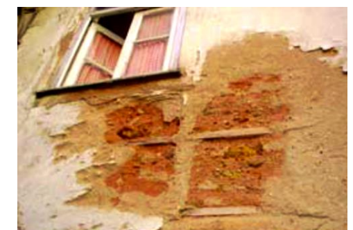
42 | Parede em enxaimel num edifício da Rua Joaquim António de Aguiar; Fonte: GCH.
