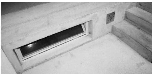
49 | Janela da cozinha, vista a partir do terraço do piso 1; Fonte: Arquivo pessoal.
