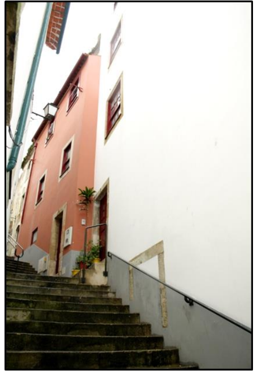
Figura 2 - Edifício localizado na Alta, alvo de Reabilitação, ao abrigo dos programas explanados anteriormente.
