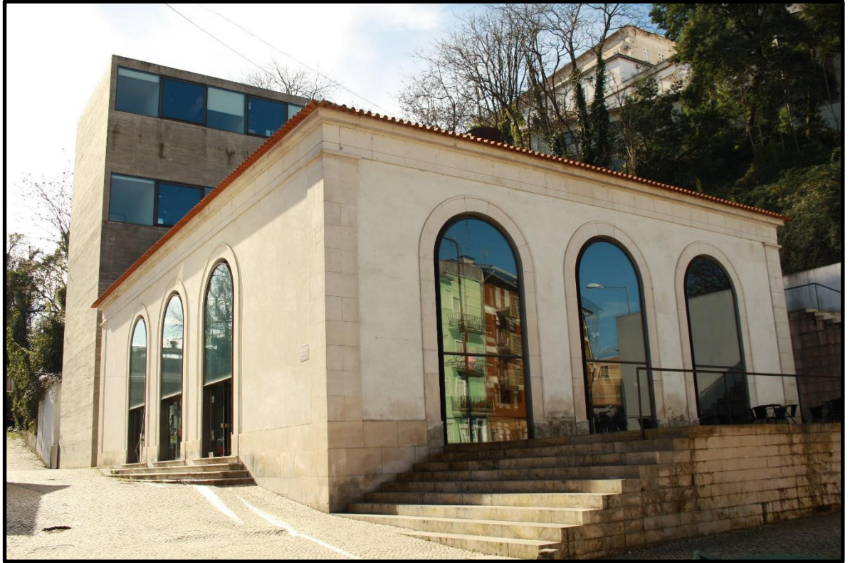
Figura 14- Casa das Caldeiras (12).
