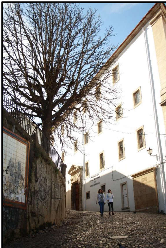
Figura 31 (à esquerda) – Colégio de Santo Agostinho (29). Funcionam neste colégio a Faculdade de Psicologia e Ciências da Educação e serviços culturais da Santa Casa. Está previsto esta Faculdade transferir-se para novas instalações.
