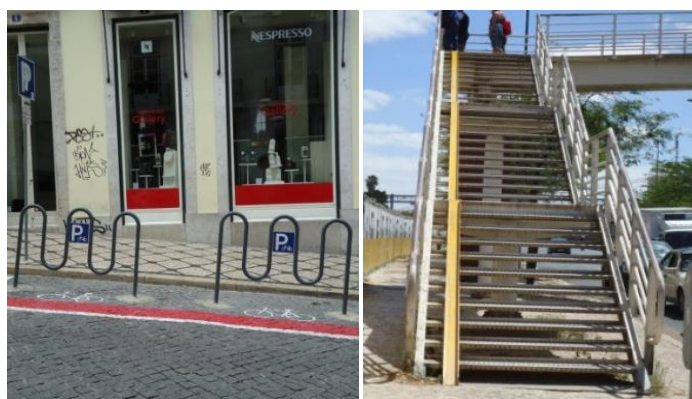
Figuras 6.3: Exemplo de algumas estruturas para bicicletas: estacionamento para bicicletas no Chiado em Lisboa, calha para bicicletas na zona de Belém, em Lisboa.
