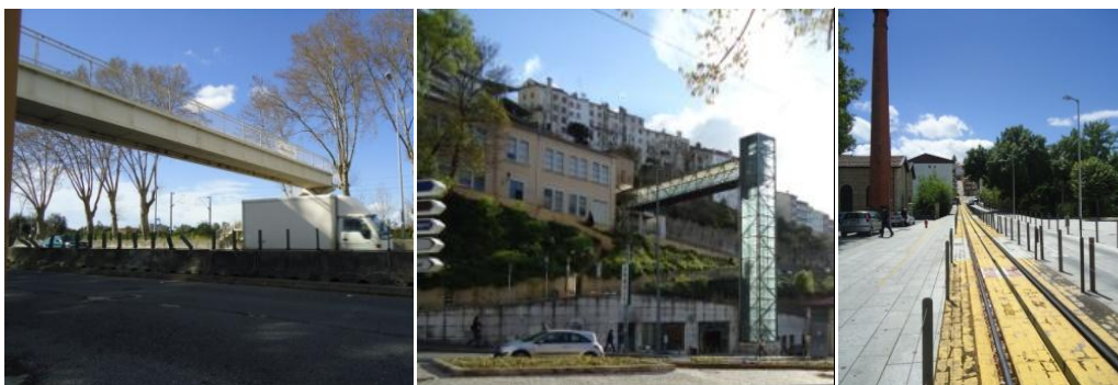
Figuras 5.9 Alguns exemplos de estruturas facilitadoras da deslocação pedonal existentes em Coimbra (ponte pedonal em Bencanta e elevador junto ao mercado) e em Viseu (funicular).
