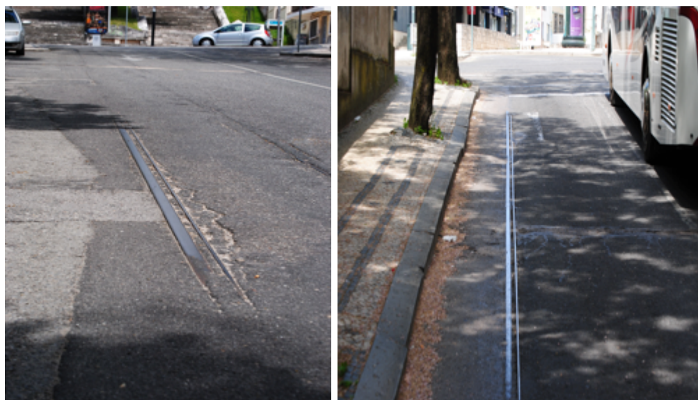
Figura 43 - Vestígios das linhas 4 e 7 do elétrico junto ao Largo de Celas em Coimbra. Fonte: autor (2013)
