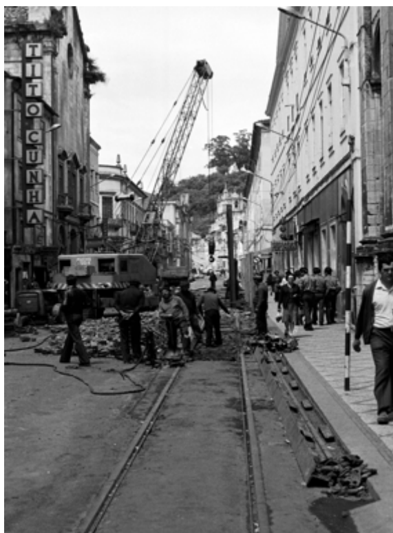
Figura 42 - Retirada dos carris da Rua da Sofia em Coimbra. Fonte: Nevenius, 1979
