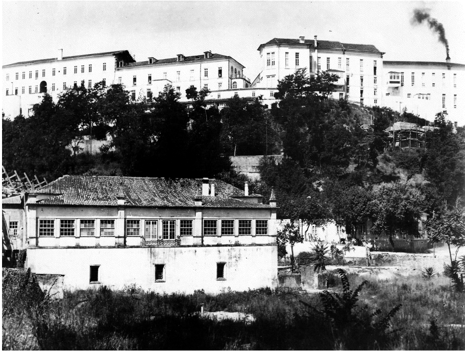
fig. 118 – Imagem do Hospital na década de 1930, visível a substituição e alteamento do telhado do hospital de S. Jerónimo e à direita o início da construção do edifício da lavandaria. [A velha Alta Desaparecida : álbum comemorativo das bodas de prata da Associação dos Antigos Estudantes de Coimbra. (Coimbra: Almedina,1985): 20]
