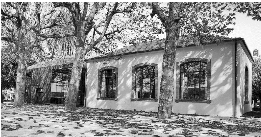
fig. 62 – Imagem atual da antiga estação de captação de água, hoje transformada em Museu da Água.
