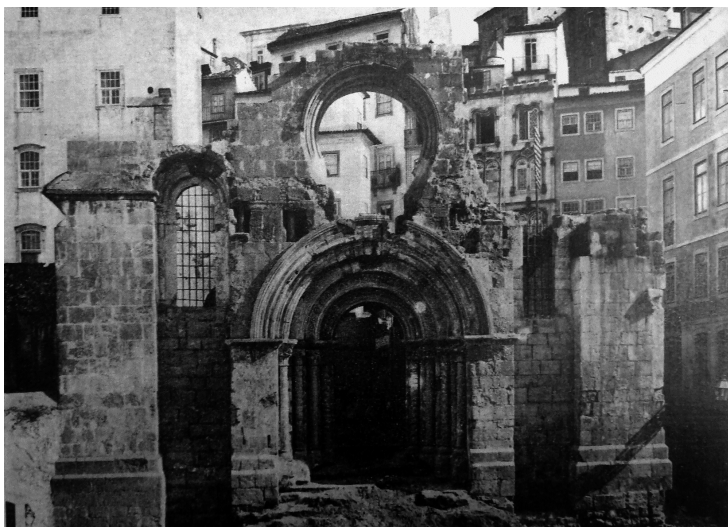
fig. 158 – Imagem do interior da Igreja de S. Tiago em obras [José Pinto Loureiro,, org, Anais do Município de Coimbra(1904-1919) ...]
