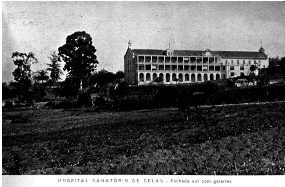
fig. 121 – Hospital Sanatório de Celas- Fachada sul com galerias [Hospital Sanatório de Celas. Coimbra (Portugal) Edição da Junta Geral do Distrito de Coimbra. Porto: Tip. Marques]
