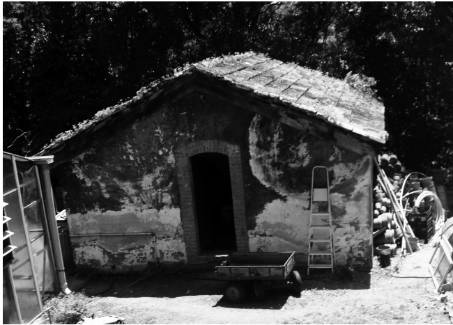
fig. 64 – Imagem atual da entrada do reservatório do Botânico
