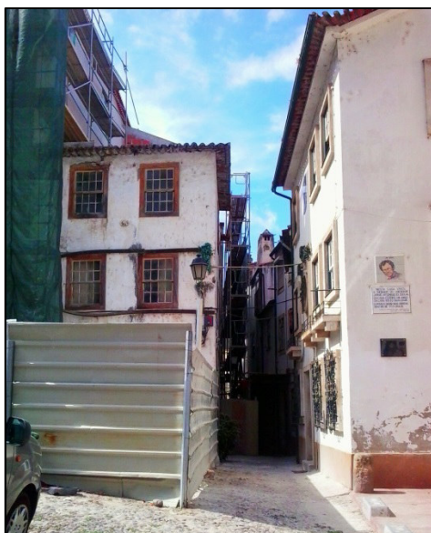
Figura 39 – Obras de requalificação de edifícios no centro urbano, neste caso, no largo da Sé Velha.
