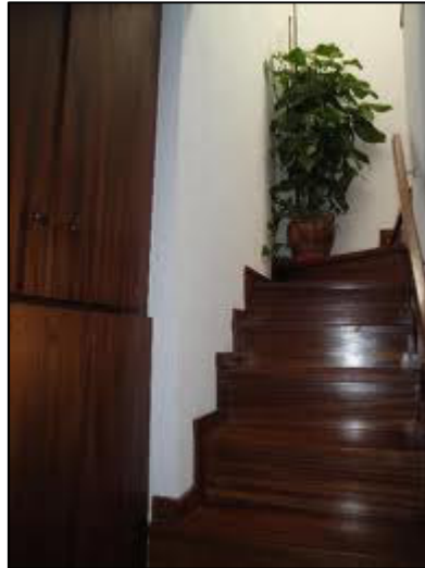
Figura 13 - Escadas de acesso de um dos edifícios da Rua Ferreira Borges, recentemente restauradas.
