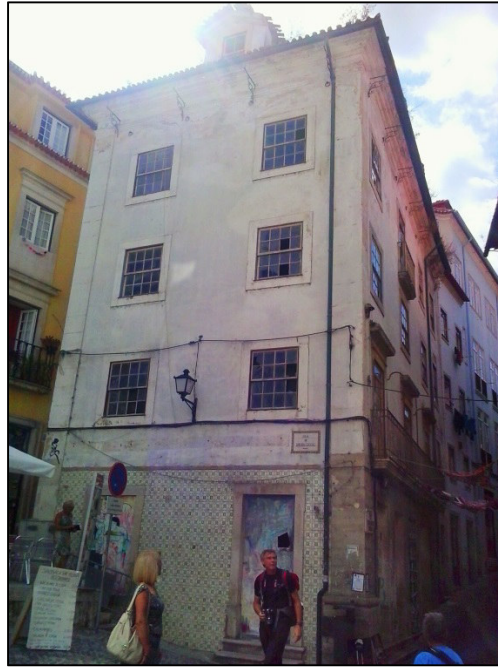
Figura 40 – Edifício devoluto limpo com entradas tapadas para impedir a entrada de lixo e ocupantes indesejados.
