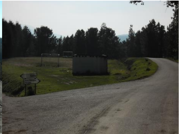
Fot. 15 - Ponto de água no cruzamento da estrada de Vale de Moreiro.
