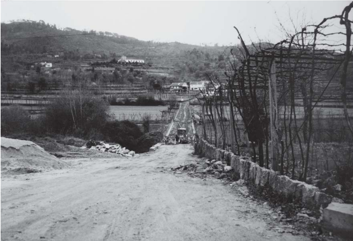
25. Obras de pavimentação de caminho agrícola, Nogueira, Ponte da Barca, anos 90. Fotografia do arquivo municipal de Ponte da Barca.
