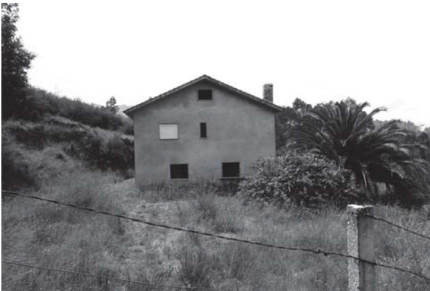
90. Segunda casa (inacabada), iniciada em 1993. Fotografia do autor, 2014.
