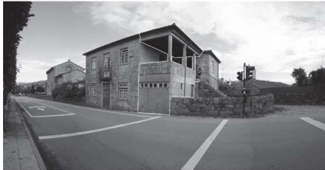
56. Casa Paroquial com marcação do volume alterado nos anos 80.
