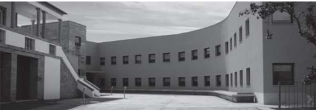
80. Residência sénior “Casa da Cerca”, Ponte da Barca, 2009, Arq.s Luísa Meneses, Pedro Baía, Joana Couceiro e Tiago Branco Sampaio
