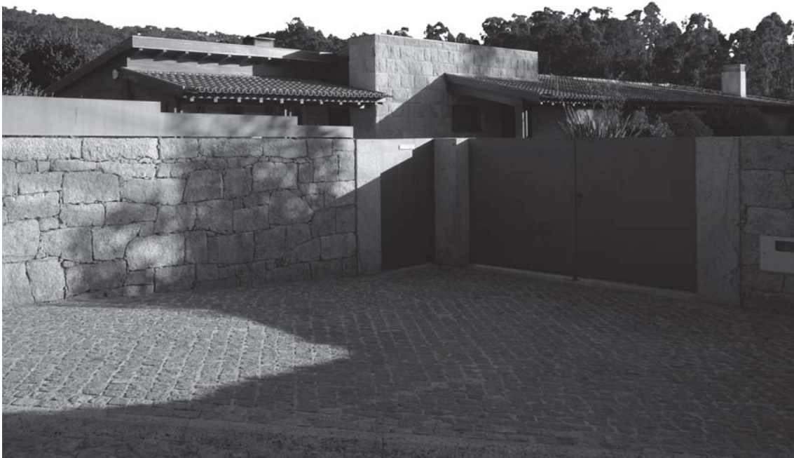
118. Casa Costa vista desde caminho público
