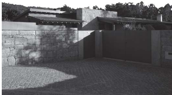
130. Entrada, vista da via pública.
