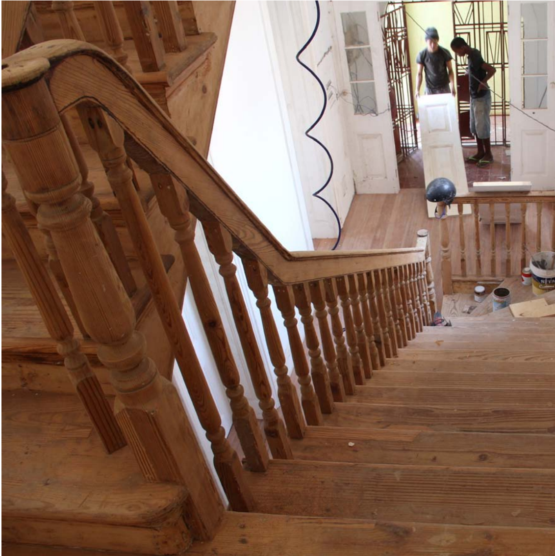
75. Vista das escadas interiores durante a intervenção
