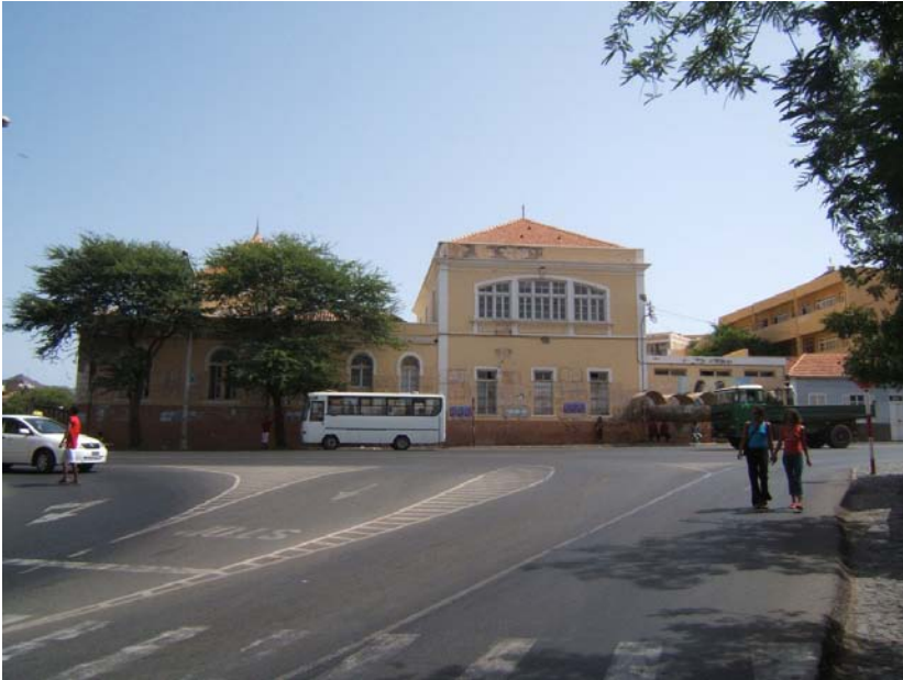
6. Vista do Alçado Sul
