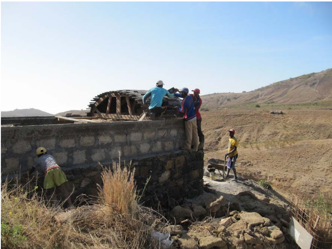
69. Construção de uma habitação com a tecnologia das abóbadas
