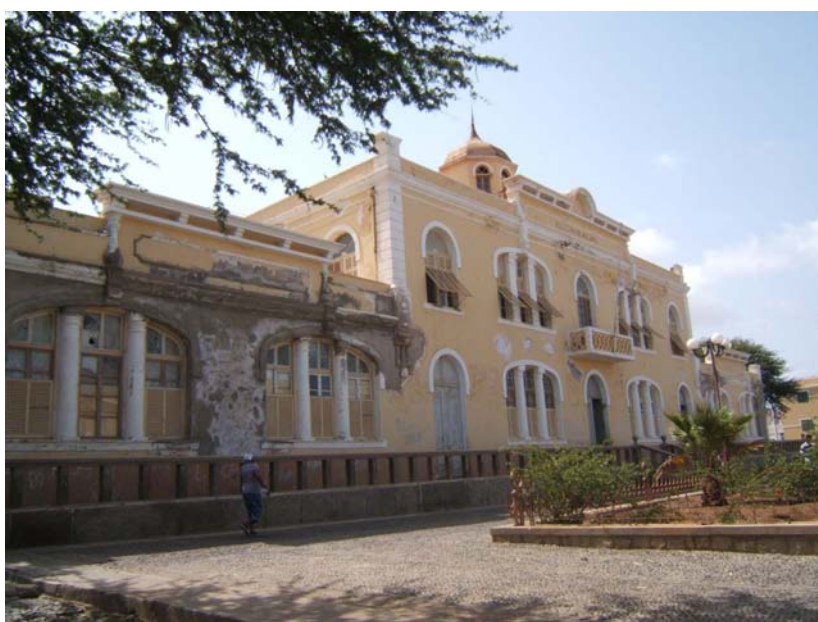
5. Alçado principal do edifício do Liceu Velho
