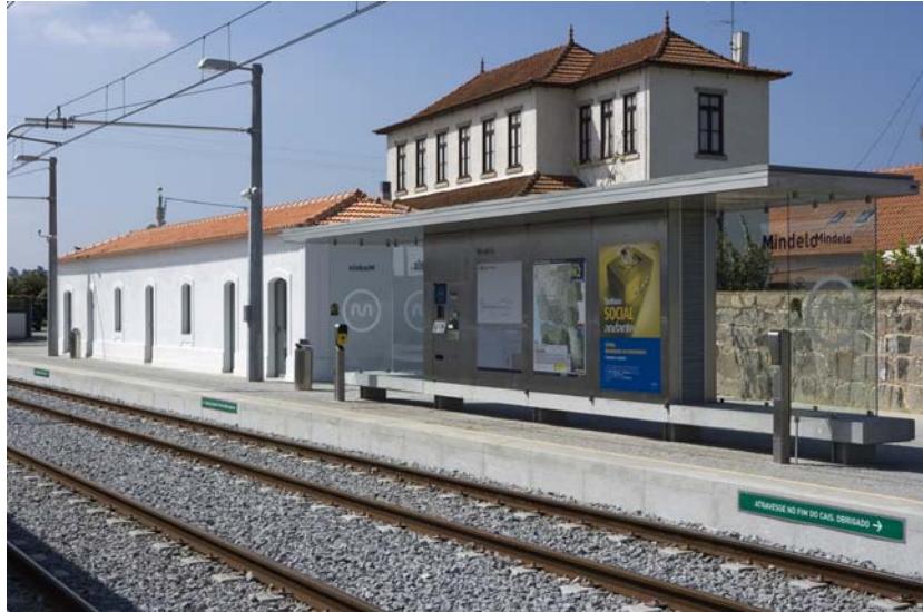
20. Metro do Porto, Estação de Mindelo
