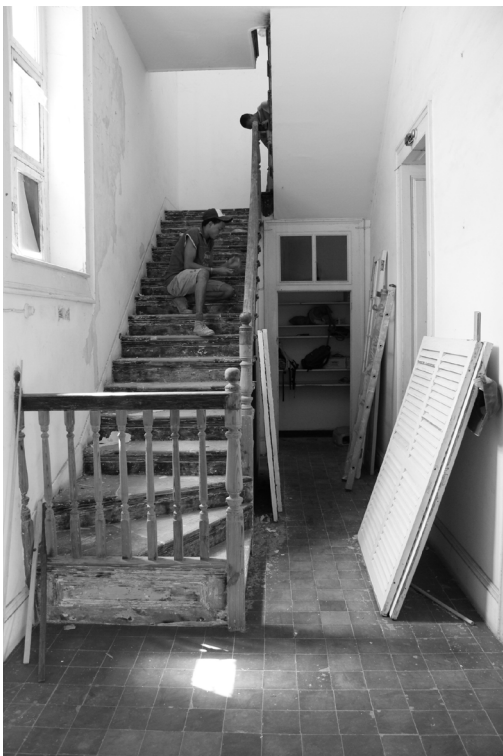
73. Vista das escadas interiores durante a intervenção
