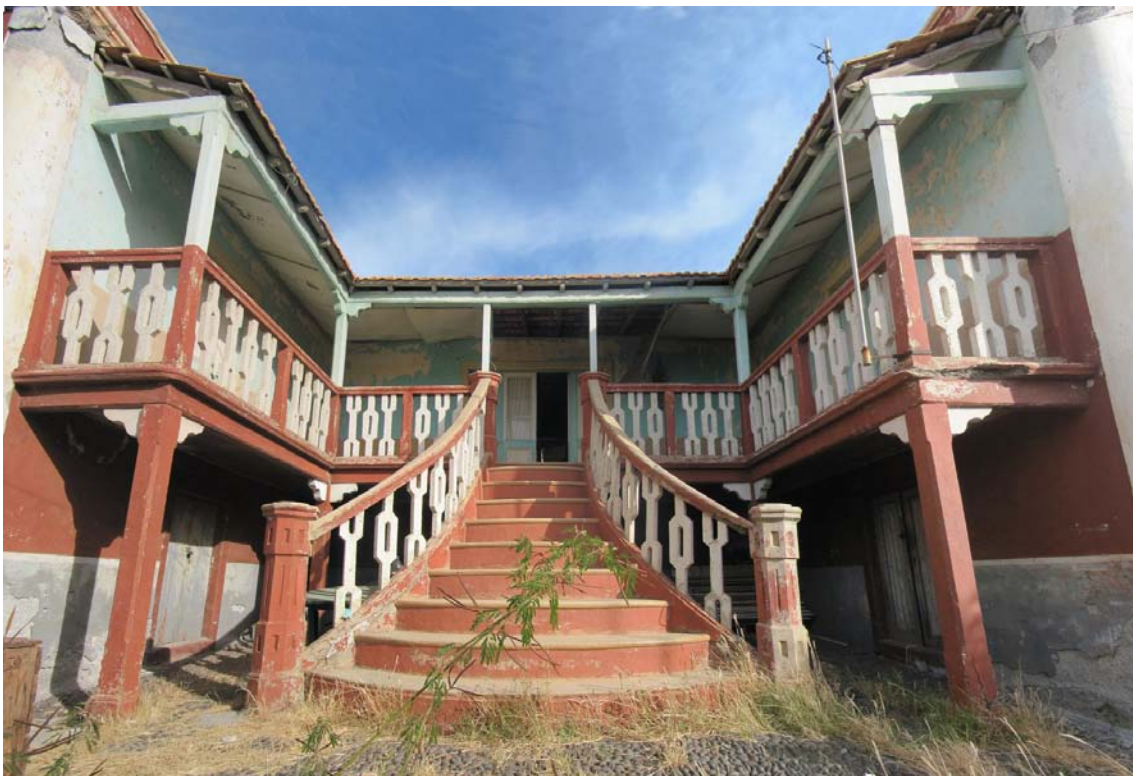
78. Vista do alpendre da "Residência Tarrafal"
