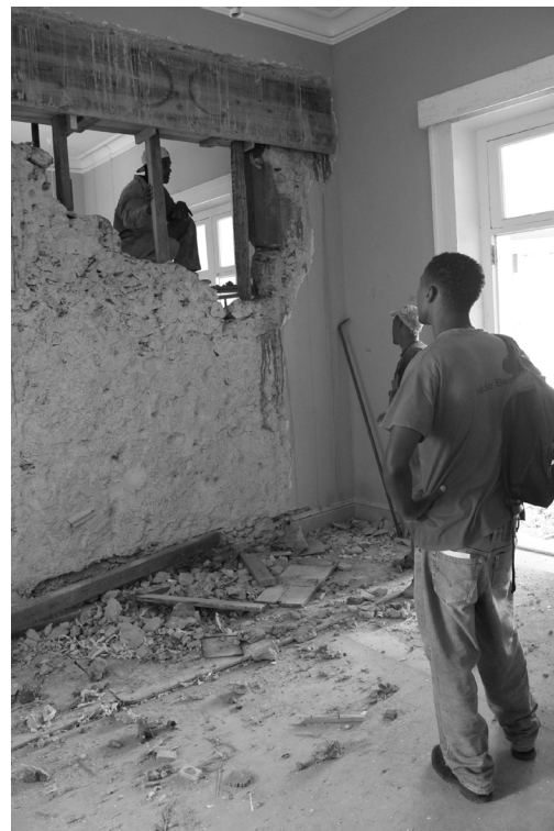
74. Demolição da parede interior
