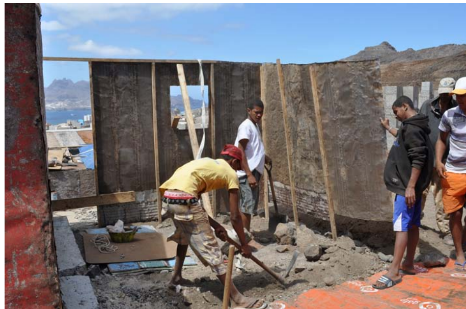
84. Construção de casa de lata na periferia de Mindelo
