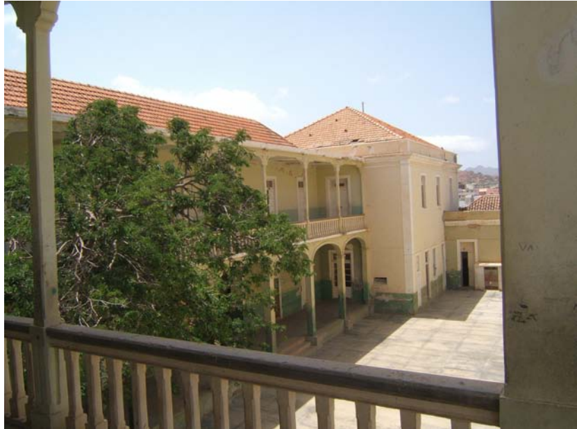
8. Vista do pátio a partir da galeria do primeiro piso
