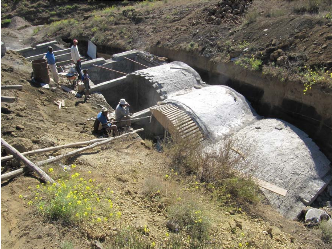
68. Construção dos depósitos
