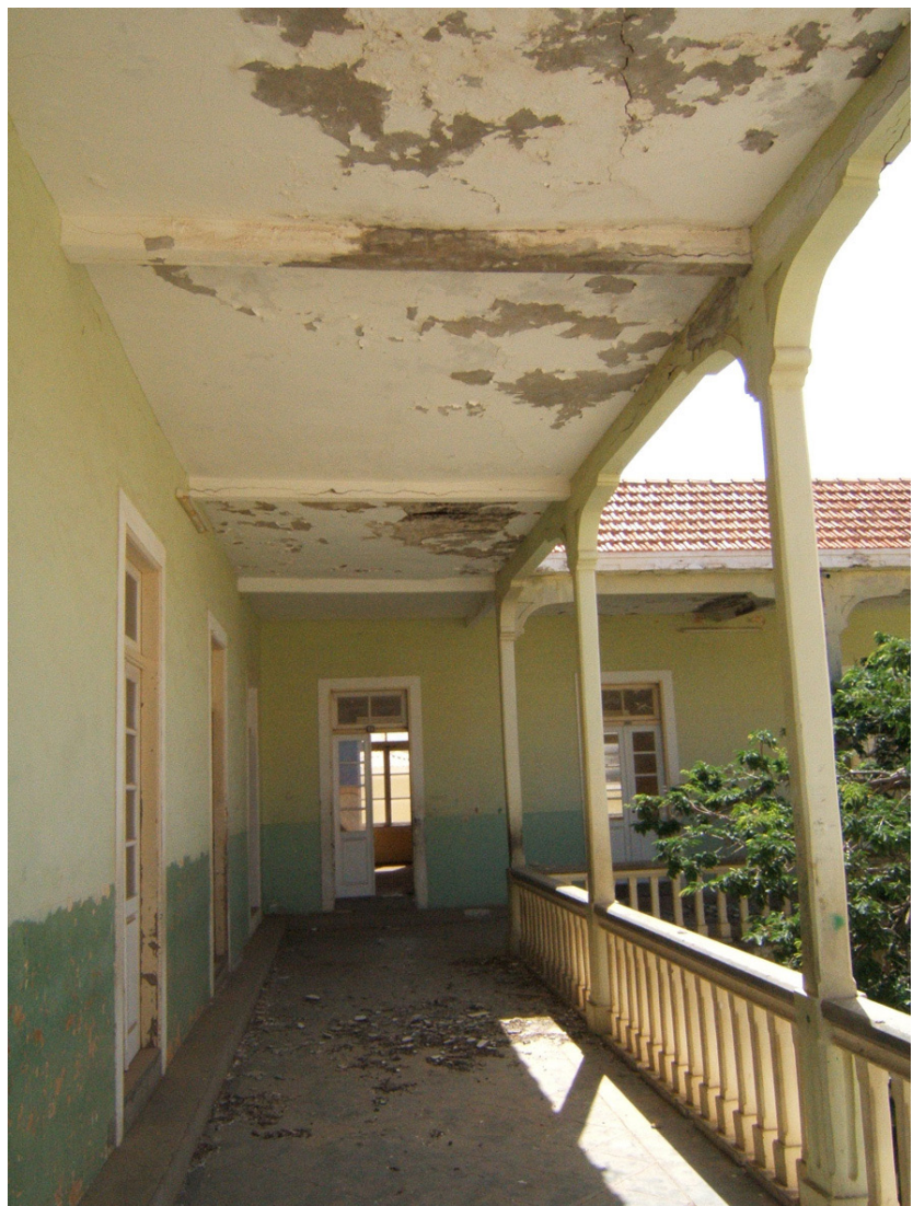
9. Vista da galeria do primeiro piso
