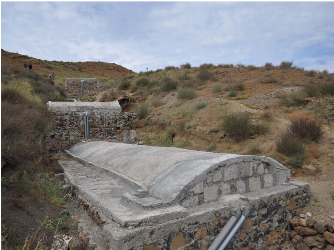
67. Vista do conjunto dos depósitos
