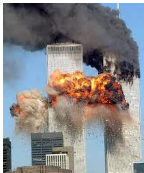
Figura 05 – Queda Torres Gêmeas (EUA)
