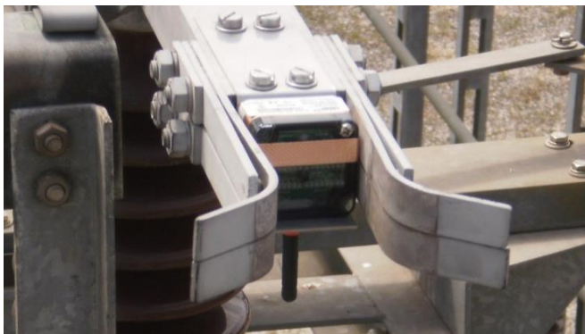
Figura 32: Primeira instalação em seccionadores.
