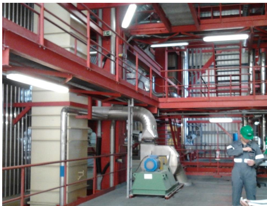
Figura 50: Espaço de implementação na SOPORCEL.
