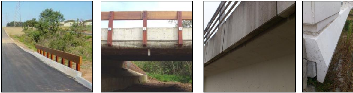
(Ponte 02 do Campus II da USP) Fonte: (Calil Jr, 2006)
