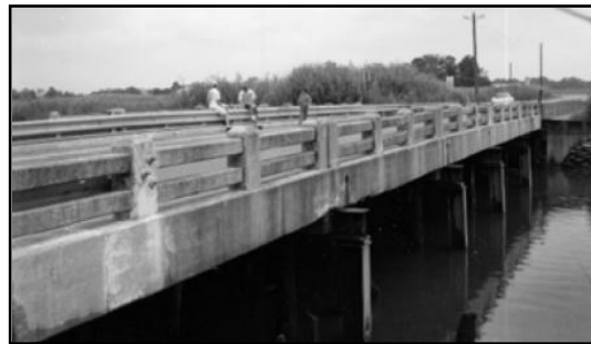
Ponte Mill Creek (Ponte Estatal K-9A), 1936 Fonte: (DeIDOT, 2000)
