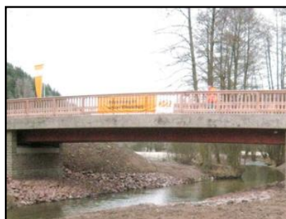
Ponte Birkberg, Alemanha (2008)
