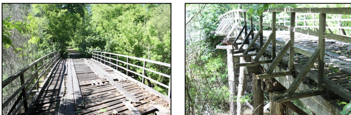
Figura 8.4 – Pavimento e guarda-corpos.
