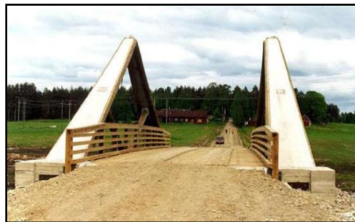
Figura 3.11 – Ponte Lehmilahti , Finlândia. Fonte: (Mäkipuro e Yli-Villamo, 2001)
