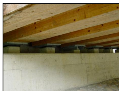
(Ponte Schachenhusbrugg) Fonte: (Swiss Timber Bridges, sem data)
