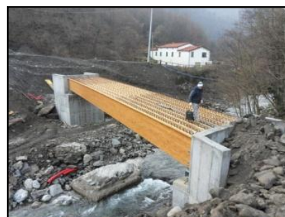
Ponte em Pracchia (fase de construção), Itália (2012)
