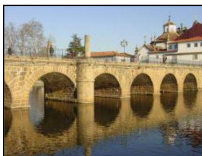
Figura 6.1 – Ponte de Trajano , Chaves.
