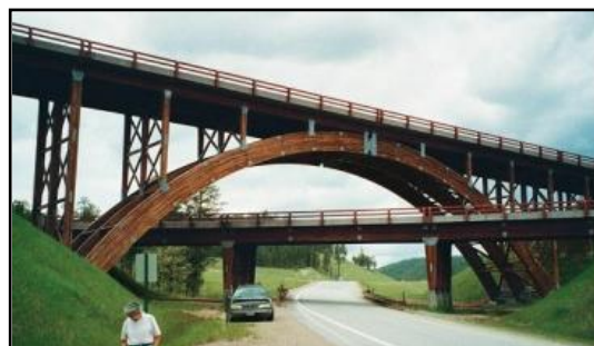
Ponte Keystone Wye, 1968 Fonte: (Structurae, sem data)
