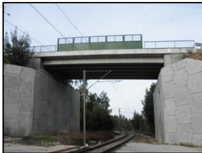
Figura 5.7 – Ponte rodoviária ao km 193+090 da Linha do Oeste, Estudo de Caso I.
