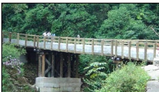
Ponte Caminho do Mar, 2004
