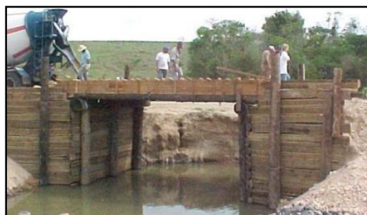
Ponte Capela (fase de construção), 2002
