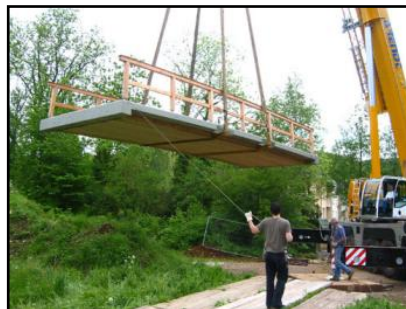
Ponte em Kayl (fase de construção), Luxemburgo (2006)
