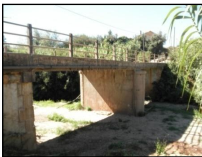
Figura 6.9 – Ponte sobre o rio Dueça, Sobral de Ceira (maior vão = 10 m).
