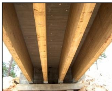
(Ponte de Quiaios – vista inferior do tabuleiro)
