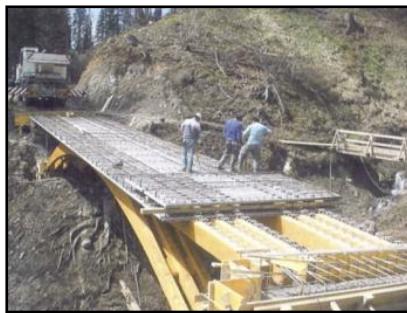
Figura 2.6 – Ponte Ragoztobel , Suíça – colocação das pré-lajes de betão armado. Fonte: (Swiss Timber Bridges, sem data)
