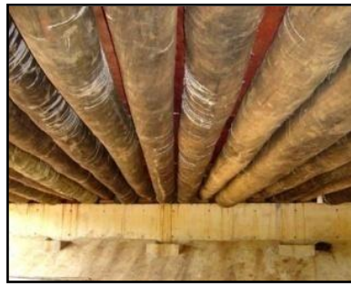
(Ponte 02 do Campus II da USP) Fonte: (Calil Jr, 2006)
