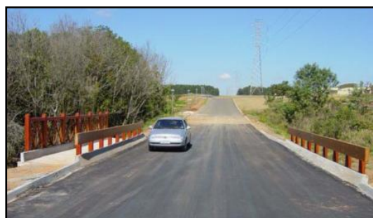
Ponte 02 do Campus II da USP, 2005
