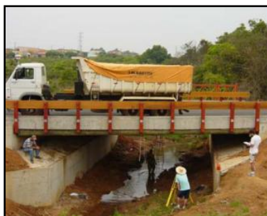
Ponte 01 do Campus II da USP
