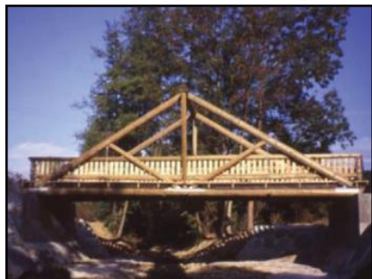
Ponte sobre o rio Sanne, França (1998)
