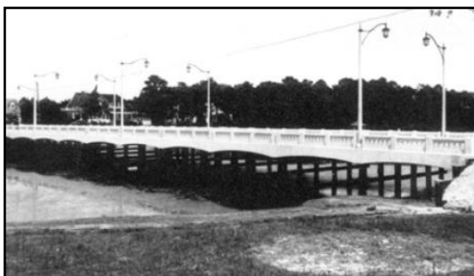
Ponte Silver Lake (Ponte Estatal S-707), 1938 Fonte: (McCullough, 1943)
