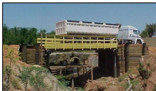
Ponte Paredão Vermelho, 2002
