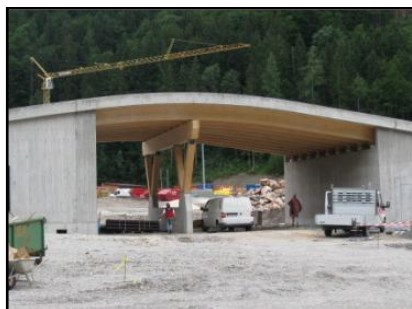
Ponte em Ruhpolding (fase de construção), Alemanha (2010)
