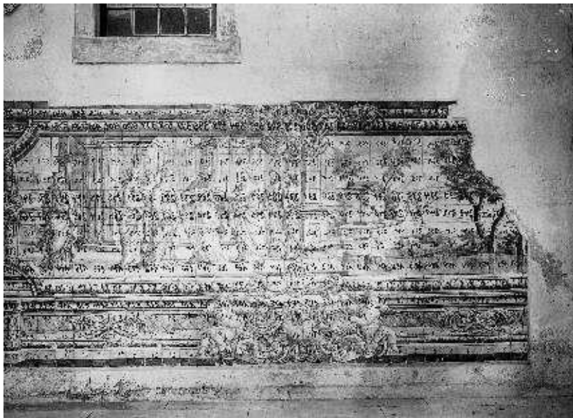
305 e 306 – Numeração dos azulejos antes de se proceder à sua retirada.
