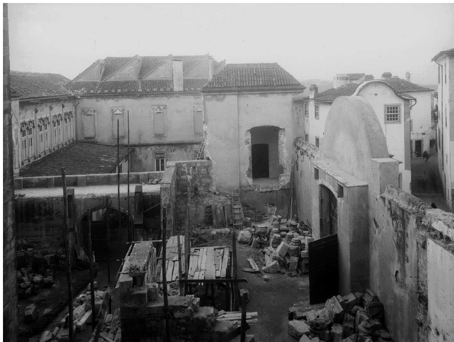
231 – Demolições no quadrante Nordeste.
