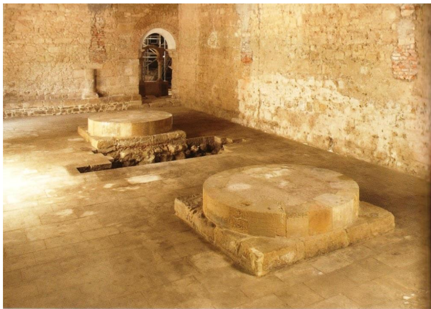
167 – Porta de acesso ao claustro e base dos pilares (entre 2004 a 2008).
