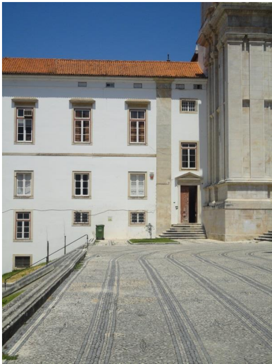
141 – Porta, disposta no lado Sudoeste, que ladeia a fachada da Sé Nova.
