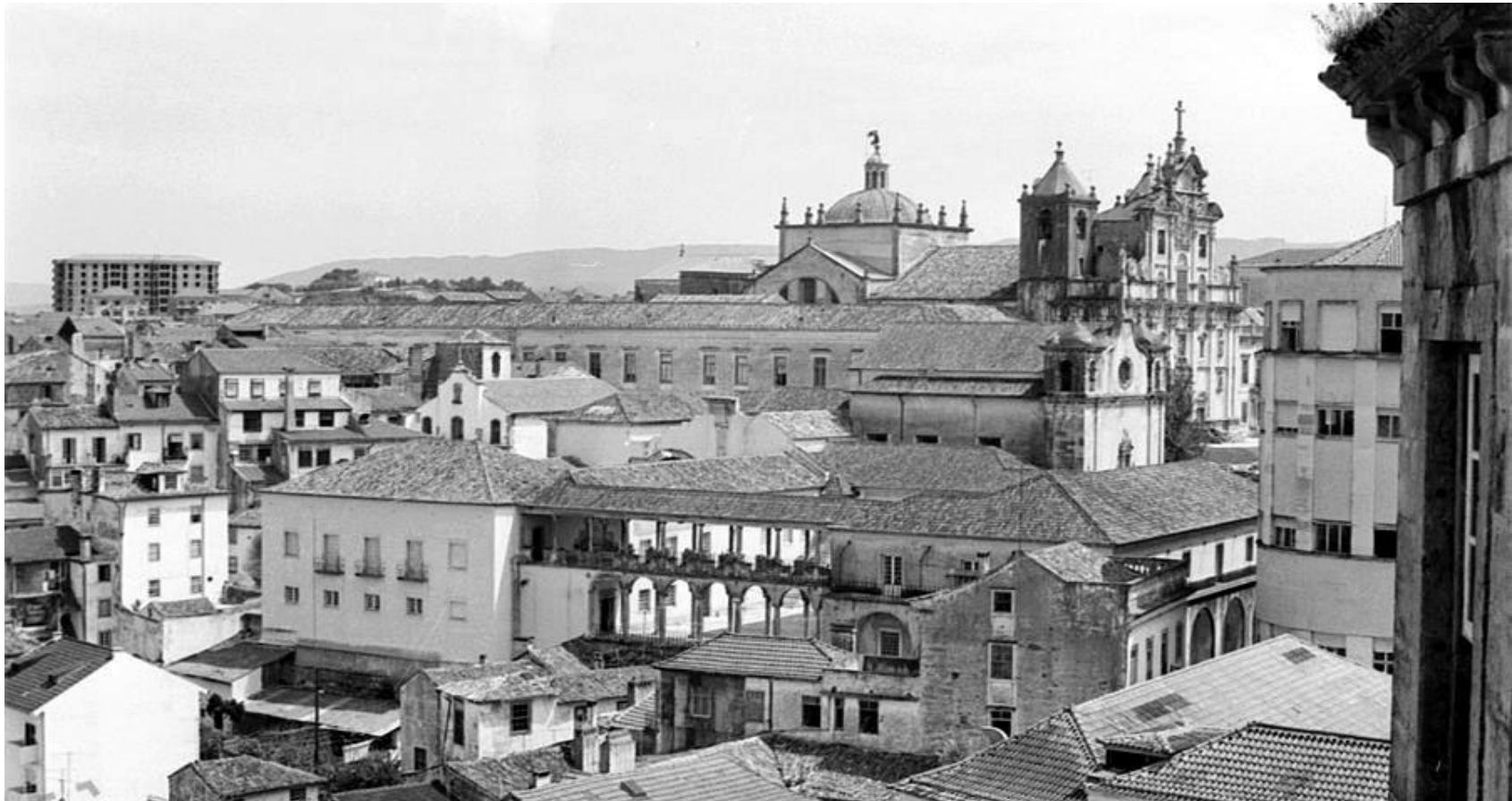
370 – Pormenor da loggia . Ausência dos dois primeiros arcos (sentido Norte-Sul).
