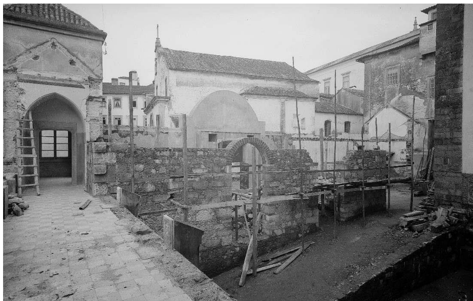
233 – Antigo passadiço neomanuelino e início da construção do novo pavilhão
