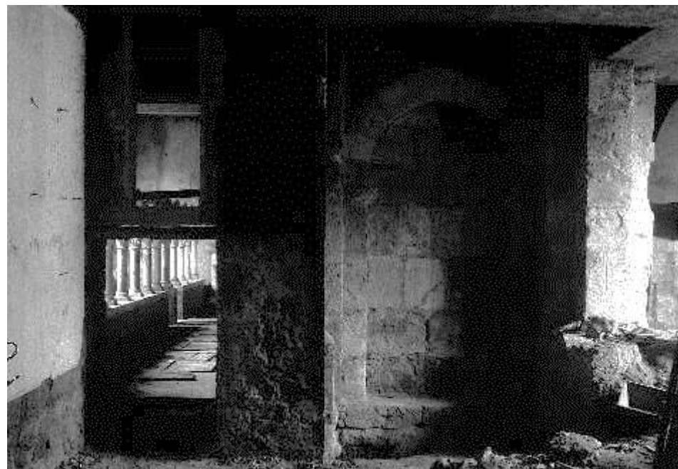
168 – Arcada cega e o tramo sul do claustro já reconstruído (1934-1935).
