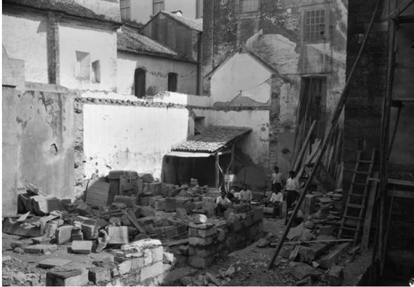
229 e 230 – Demolições no quadrante Nordeste.
