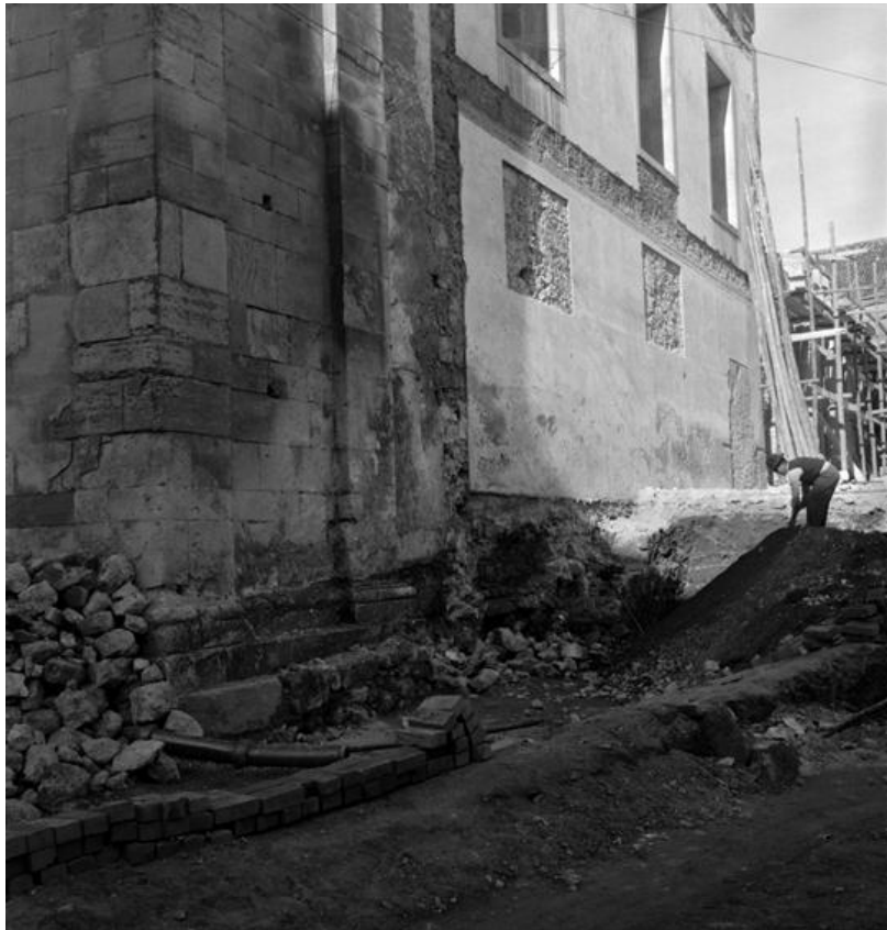
380 – Fachada da igreja de São João de Almedina durante as obras de rebaixamento da rua do Arco do Bispo.
