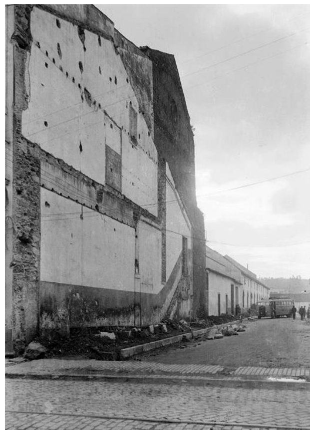
417 – Área onde se procedeu às demolições.
