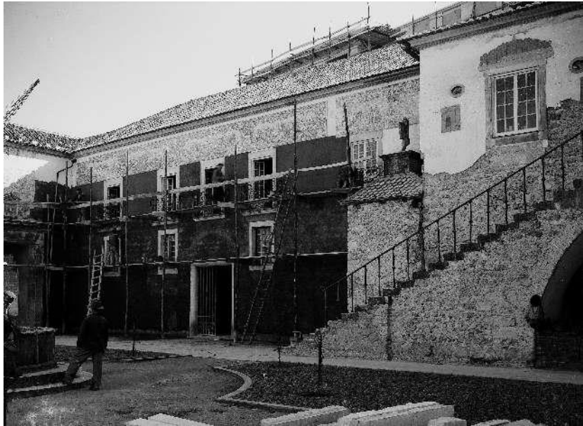
309 e 310 – Intervenções na fachada Sul do pátio principal.
