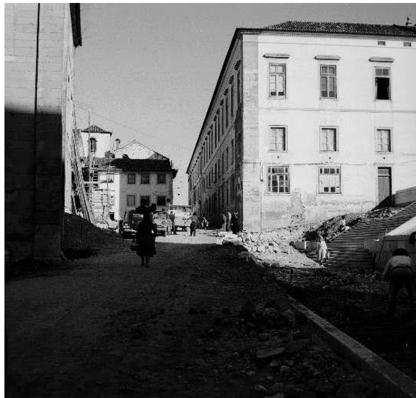
387 – Construção do anexo (1956-1957)
