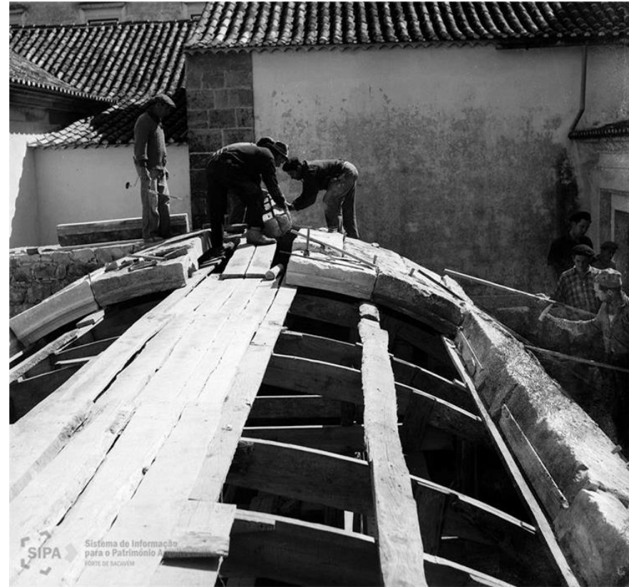
436 e 437 – Montagem da abóbada (1967).
