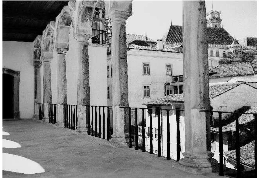
308 – Colocação de grades de ferro entre as colunas da parte inferior da loggia .
