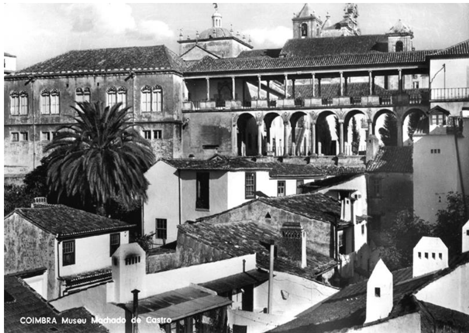
99 – Janelas neomanuelinas localizadas no corpo Noroeste (postal dos inícios da década de 1940).
