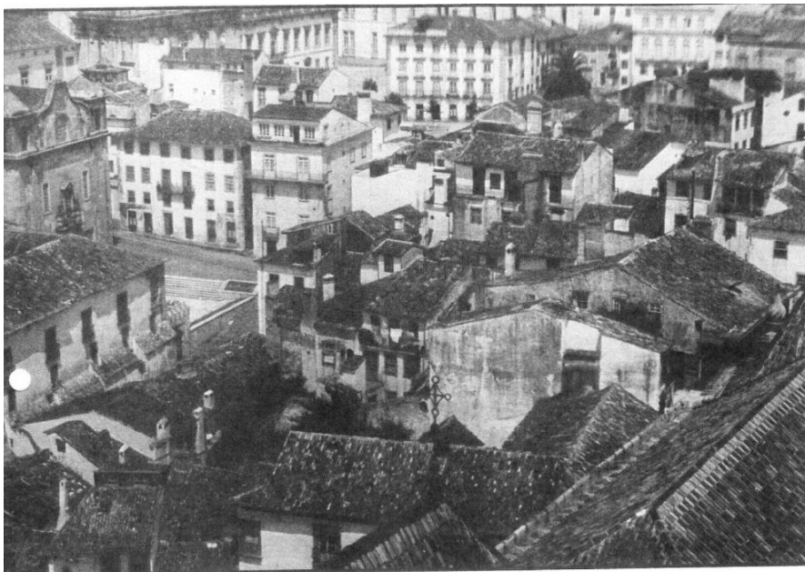
254 – Cintura habitacional disposta nas proximidades da fachada Sul do Museu Machado de Castro, demolida nos inícios da década de 40 para dar lugar à Faculdade de Letras da Universidade de Coimbra.
