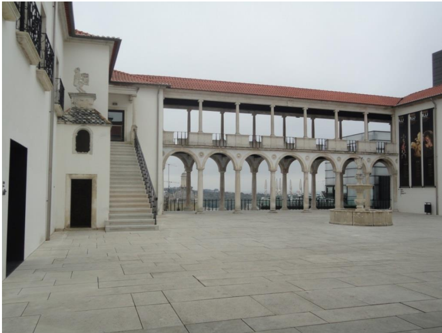
81 – Torre sineira, escadaria de acesso ao primeiro andar e loggia .
