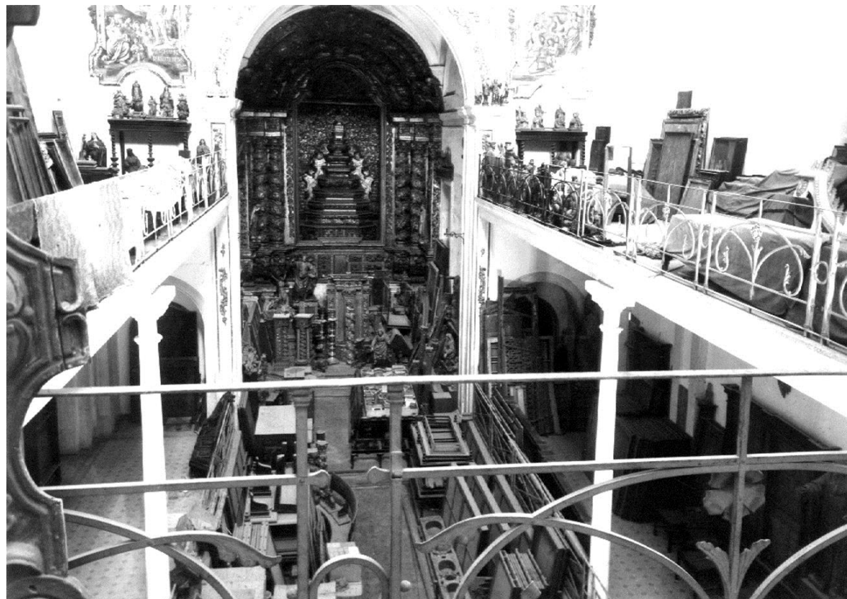
154 – Fotografia realizada nos finais da década de 1940. Saliente-se que, nessa altura, o espaço serviu de depósito do acervo do MMC. Atenda-se ao pormenor das galerias laterais do primeiro andar, contíguas ao coro.
