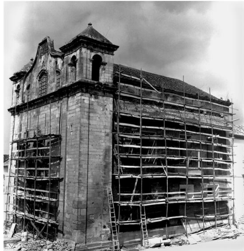
381 – Fachada principal e lateral da igreja de São João de Almedina durante as obras de 1957.
