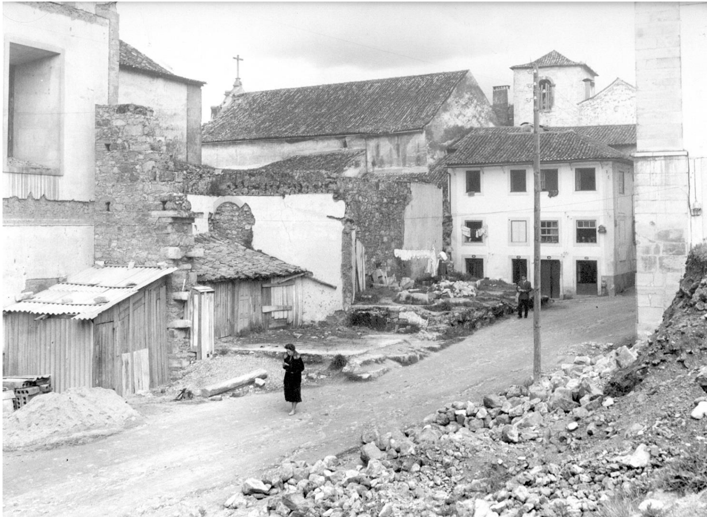
261 – Espaços dispostos a Nascente já demolidos, juntamente com o arco do bispo (fotografia realizada a partir de Abril de 1948).
