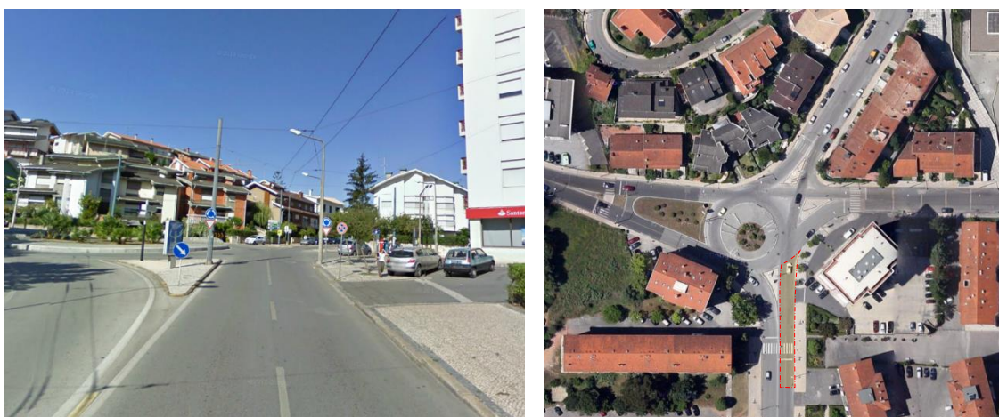
Rotunda da Solum – Coimbra (entrada sul) Duas vias de entrada e duas vias de circulação (mal definidas)
