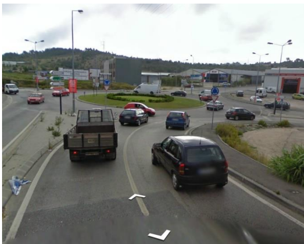
Rotunda da Pedrulha – Coimbra (entrada oeste) Duas vias de entrada e duas vias de circulação (mal definidas)
