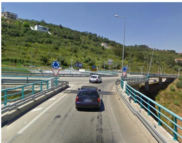
Rotunda da Ponte Rainha Santa – Coimbra Uma via de entrada e uma via de circulação
