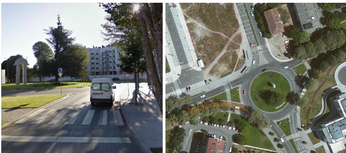
Rotunda de Nelas – Viseu (entrada oeste) Duas vias de entrada e duas vias de circulação
