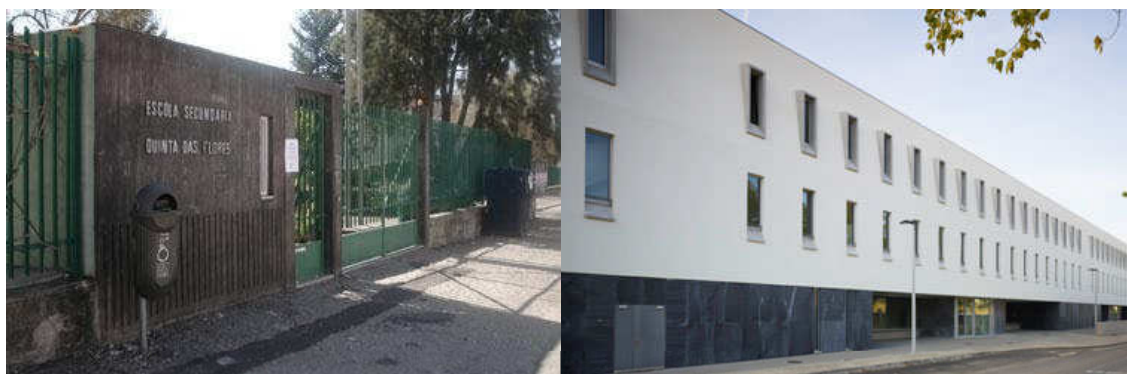
Fig. 103 e 104| Frente urbana da Escola Secundária Quinta das Flores/ Conservatório de Música, Antes e Depois da Intervenção
