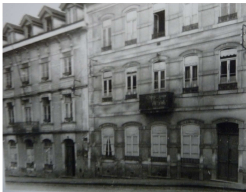
Fig. 41|Edifício nº111 da Avenida Sá da Bandeira
