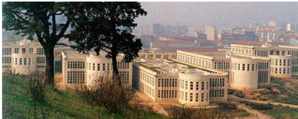
Fig. 12| Escola Secundária de Benfica, Lisboa, Imagem do conjunto
