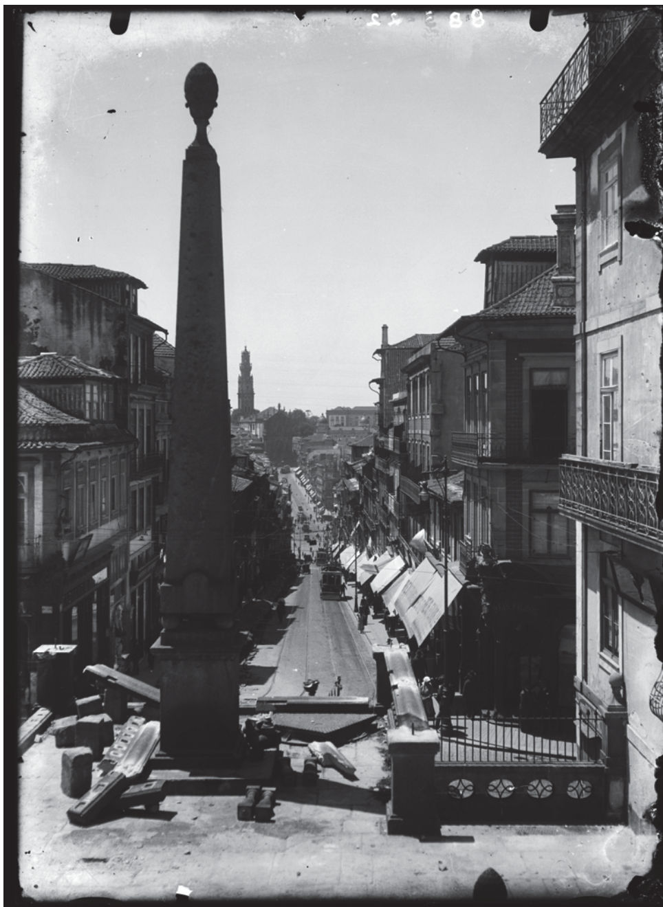
Fig. 335 , Fundo FOTOGRAFIA ALVÃO, Obelisco junto à Igreja de Santo Ildefonso, Porto , [ca. 1920-1924], © Centro Português de Fotografia, DGLAB/SEC, PT/CPF/ALV/006618 1940 .
