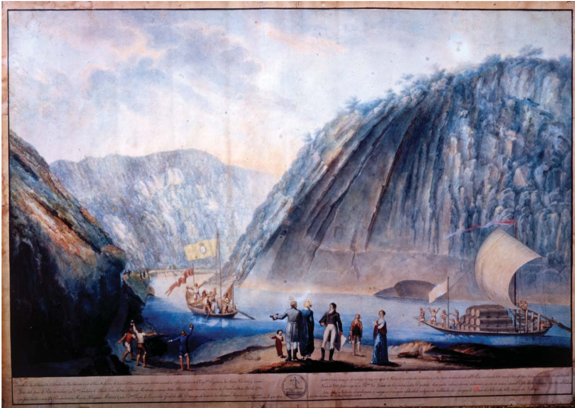
Fig. 282. João Baptista Ribeiro, Prospecto do sitio do Cachão de S. Salvador da Pesqueira, observado da parte de Tras os Montes, como elle ficou em 1792 ano em que cessou o trabalho começado em 1780 para o demolir. O Cappitam Ingeheiro Jose Maria Yola desceu o Cachão dentro d'hum barco, que foi carregar de trigo por cima de Freixo de espadacinta, e o conduziu por 30 legoas embandeirado até o Porto, mostrando deste modo o triunfo que tinha conseguido da natureza. Antes delle forão do Porto ao cachão o Ex. mo Secretario d' Estado João Antonio Salter de Mendonça, e varios illustres Patriotas como se annunciou no Correio da Europa em 19 de Abril de 1790. No ano de 1793 fizeram o mesmo os Illustrissimos Vice Provedor da Companhia, e outros Deputados: huns e outros subirão, e descerão embarcados no sitio do cachão, e tiveram o gosto de ver, e admirar esta obra ou Padrão que fará immortal o nome da Providentissima Mãe dos Portugueses Maria I, e da Illustrissima Junta da Companhia Geral do Alto Douro, que debaixo de tão Soberanos Auspícios, e as ordens pozetivas cortou os Rochedos, desembaraçou a navegação, e conseguiu a felicidade, e alegria dos habitantes das margens do Douro, do Sabor, e dos bellos campos da Villariça. Por João Baptista Ribeiro, discipulo da Real Academia, 1810; cedência de reprodução de IVDP, Instituto dos Vinhos do Douro e do Porto.
