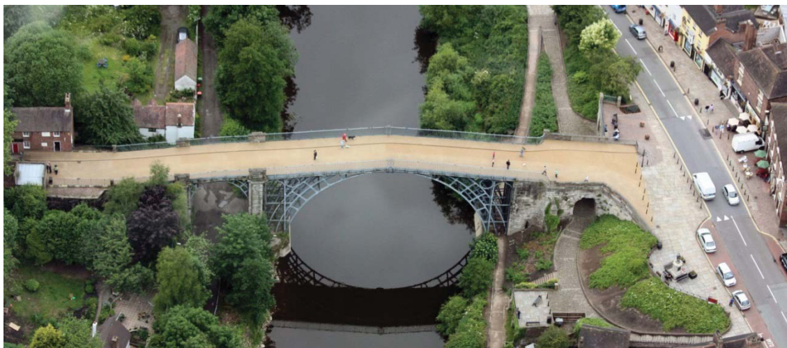
Fig. 260, Ponte de ferro fundido sobre o rio Severn (1777-1780), perto de Coalbrookdale, Grã-Bretanha; consultado em 2011-11-21, disponível em es.wikipedia.org .
