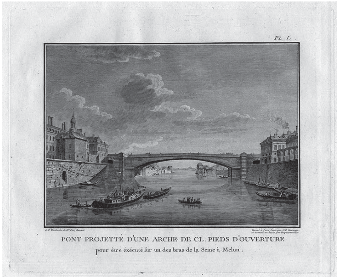
Fig. 50. PERRONET, Jean-Rodolphe, “Pont projeté d’une arche de CL. pieds d’ouverture pour être exécuté sur un des bras de la Seine à Melun”, J. F. Eustache de St. Far direxit, gravé par J. F. Germain & Dequevauviller, in Description des Projets et de la Construction des Ponts de Neuilly, de Mantes, d’Orleans et autres, du Projet du Canal de Bourgogne, Pour la Communication des deux Mers par Dijon, et de celui de la Conduite des Eaux de l’Yvette et de Bievre a Paris , Paris, Imprimerie Royale, 1782-1783, PL. L.
