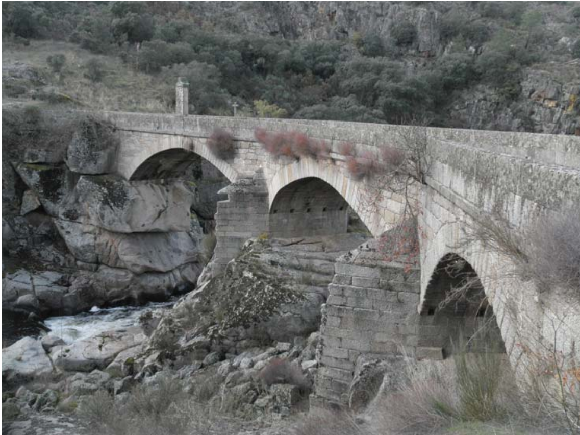
Fig. 168. Ponte Grande Sobre o Rio Côa , Azinhal, © Luís Fernandes (ponte construída em cantaria de granito no século XVII, com tabuleiro plano tripartido, constituída por três arcos segmentares; a ponte ligava Guarda a Almeida e ficou muito destruída na terceira invasão francesa; em 1824-1825, durante o reinado de D. João VI, a ponte foi objecto de profunda reconstrução, assinalada por um padrão com uma inscrição gravada em latim).
