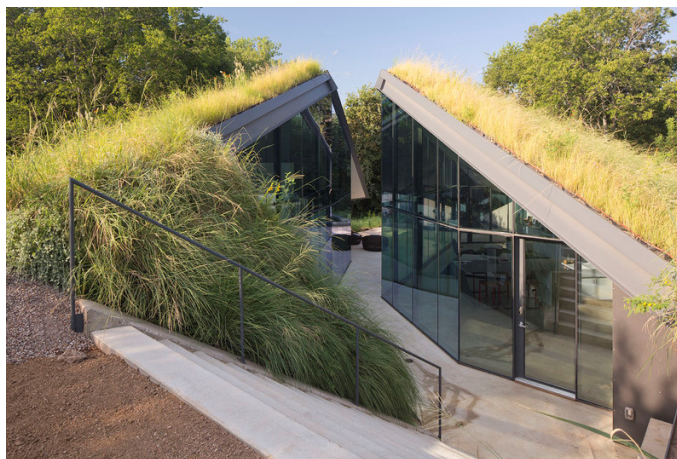
Fig. 35 – Casa Edgeland – Bercy Chen Studio (2012). Exemplo de cobertura verde semi-intensiva.
