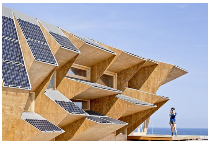
Fig. 22 – Endessa Pavillion – O Envelope do edifício é composto por um sistema modular inteligente que se reposiciona de acordo com o percurso solar.
