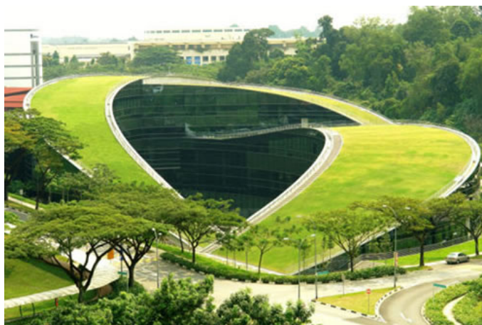
Fig. 36 – Escola de artes, design e multimédia, Nanyang – CPG consultants (2006). Exemplo de cobertura verde semi-intensiva.
