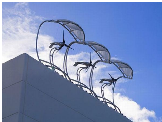
Fig. 47 – Turbina eólica de eixo horizontal na cobertura de um edifício.
