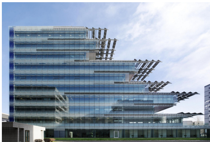
Fig. 24 – Edifício SIEEB. Fachada nascente.
