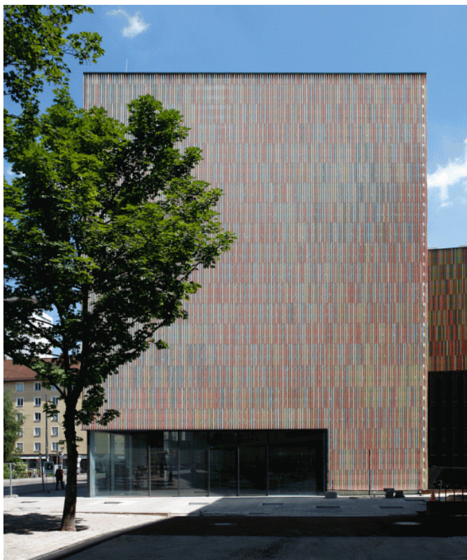
Fig. 27 – Museu Brandhorst – Sauerbruch Hutton (2009). Exemplo de fachada ventilada.
