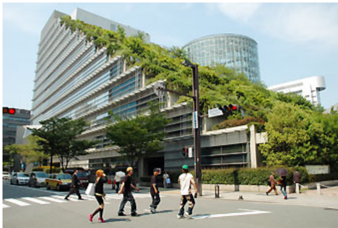
Fig. 37 – Fundação ACROS Fukuoka – Emilio Ambasz & Associates (1995). Exemplo de cobertura verde intensiva.
