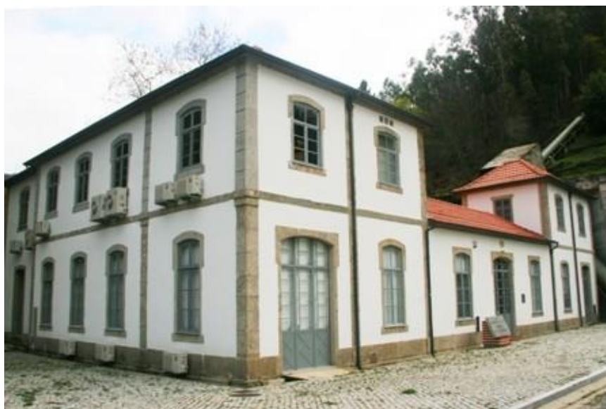
Central Eléctrica da Senhora do Desterro, actual Museu Natural da Electricidade.
