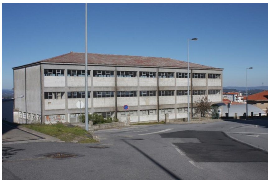
Edifício da Cantina, fotografia de Joana Orêncio.
