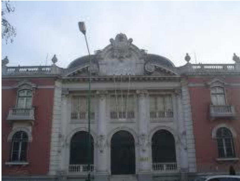
Fig 91. Fotografia da fachada principal da agência de Setúbal.
