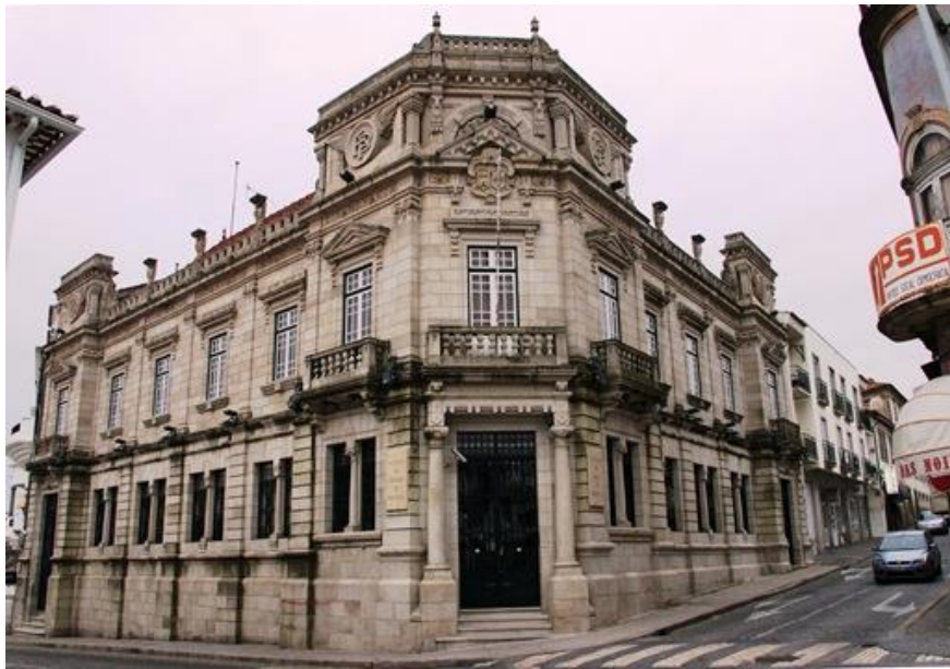
Fig 93. Fotografia do edifício da agência de Castelo Branco.
