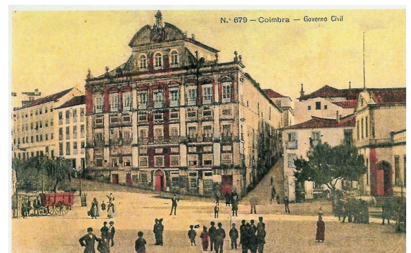
Fig 18. «Antigo» Governo Civil do distrito de Coimbra.
