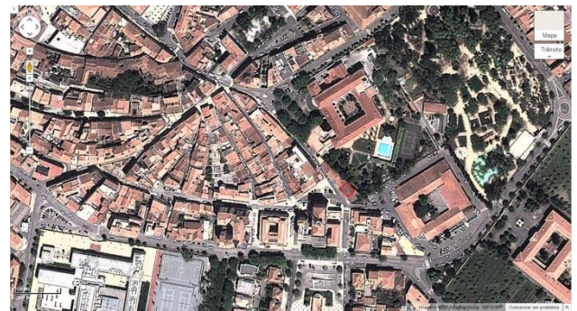
Fig 16. Vista aérea do edifício no largo 9 de Julho.
