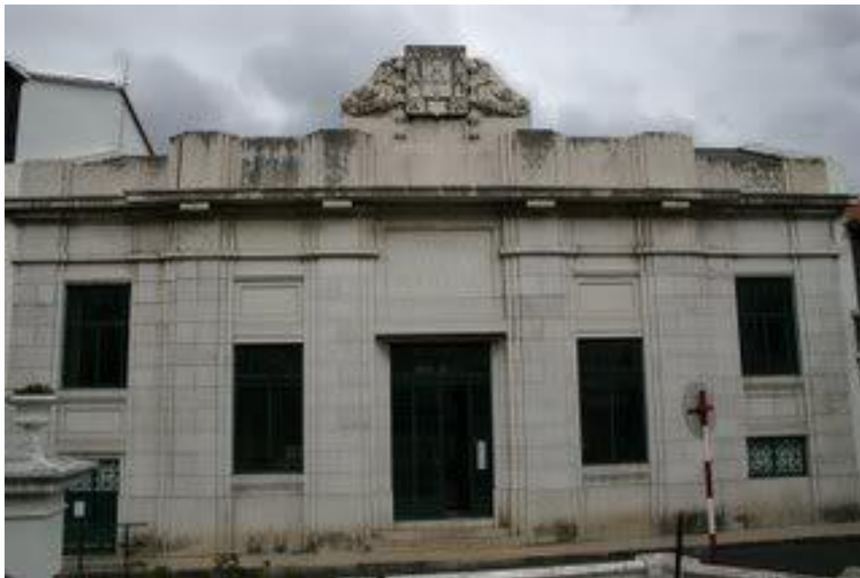
Fig 108. Fotografia do edifício da agência da Horta.
