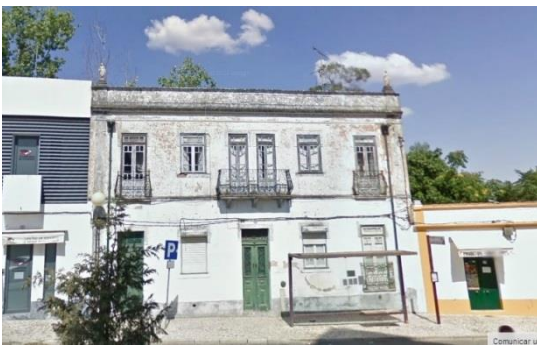
Fig 15. Edifício onde funcionou a agência de Beja.
