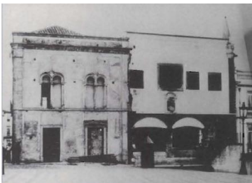
Fig 17. Edifícios demolidos para a construção da agência de Évora.
