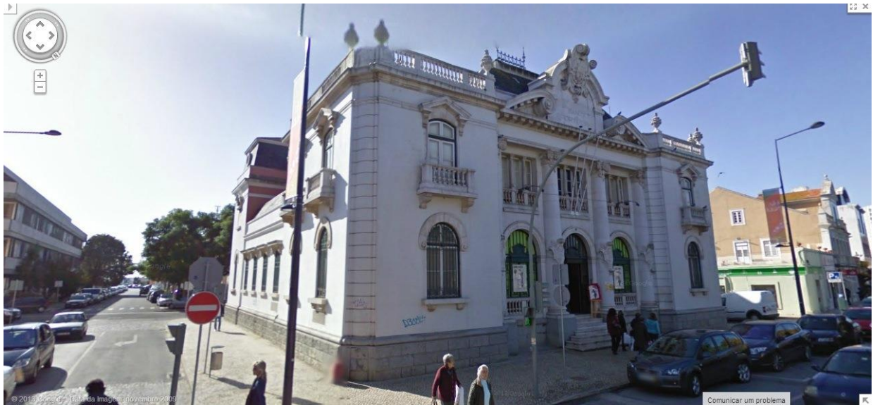
Fig 88. Vista perspectivada do edifício da agência de Setúbal.
