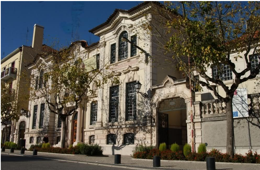
Fig 96. Fotografia do edifício da agência de Leiria.
