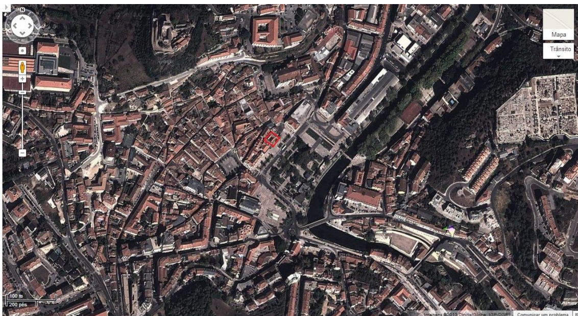
Fig 98. Vista aérea do edifício da agência de Leiria.
