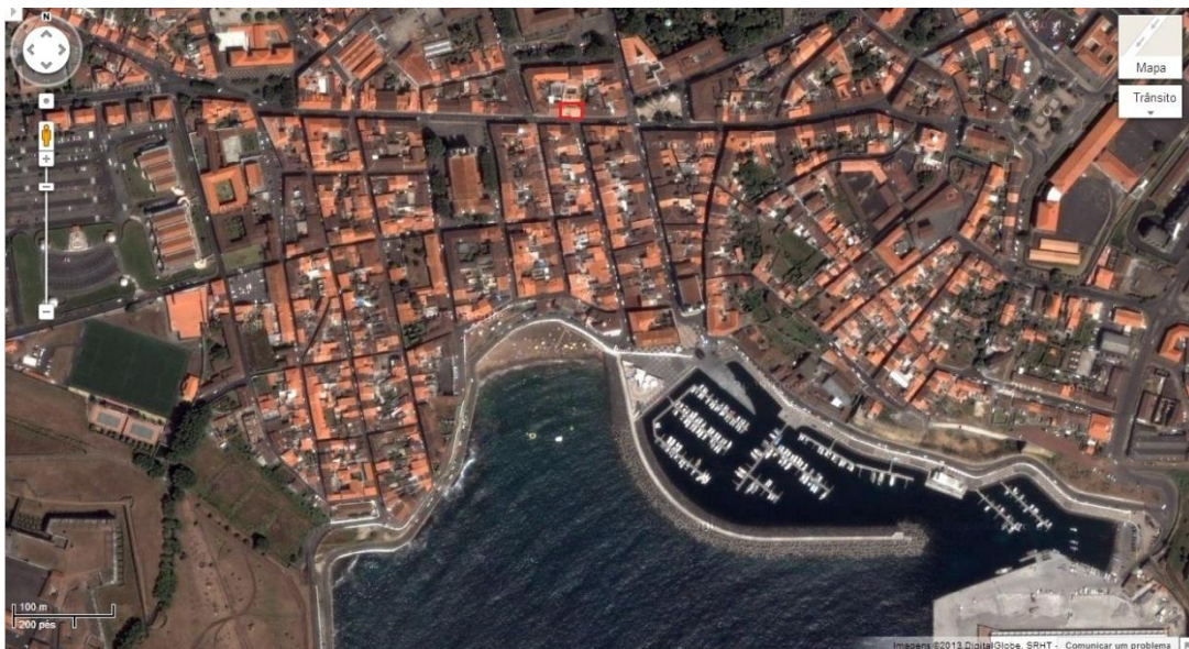
Fig 107. Vista aérea do edifício da agência de Angra do Heroísmo.
