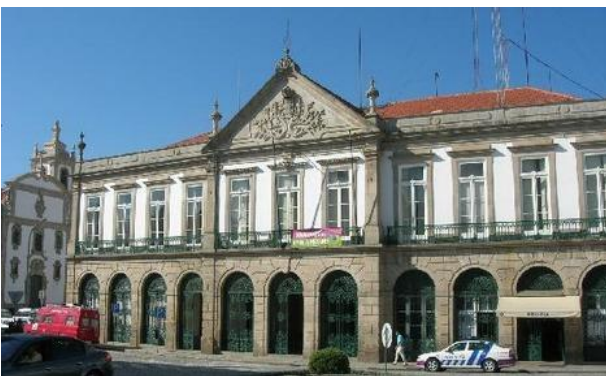
Fig 23. Governo Civil do distrito de Vila Real.
