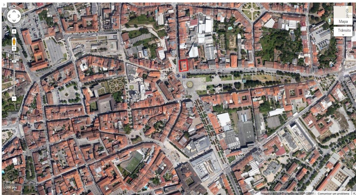
Fig 80. Vista aérea do edifício da agência de Braga.
