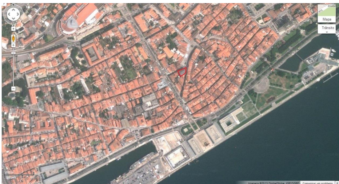
Fig 137. Vista aérea do edifício da agência de Viana do Castelo.
