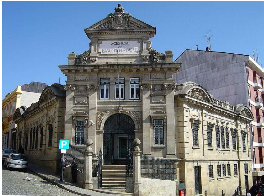
Fig 61. Fotografia do edifício da agência de Vila Real.
