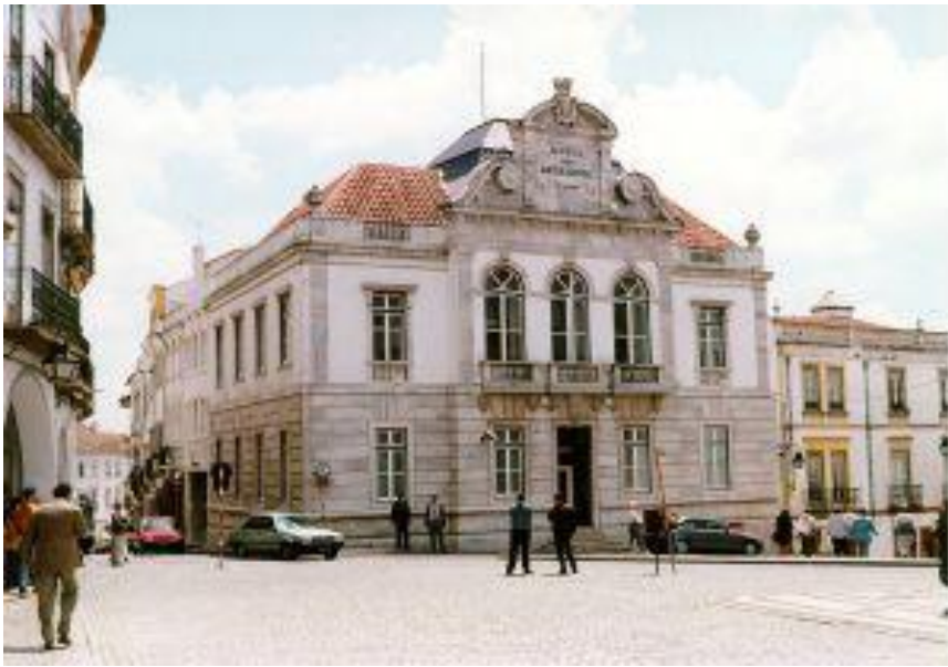
Fig 42. Fotografia do edifício da agência de Évora.
