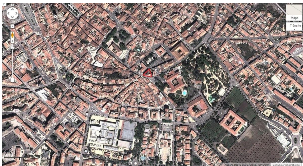
Fig 124. Vista aérea do edifício da agência de Beja.
