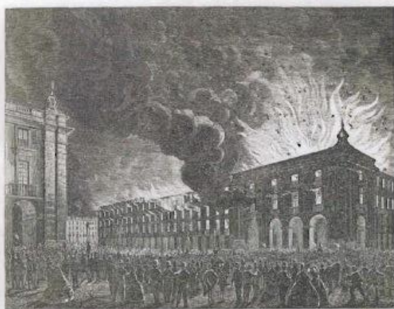
Incêndio do paço municipal de Lisboa, e do banco de Portugal
