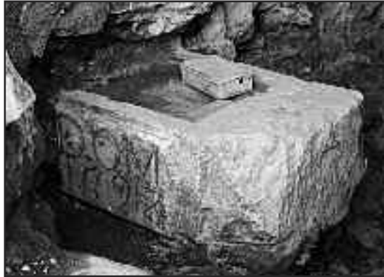
Fig. 1. Pedra angular de uma reconstrução da Universidade de Coimbra. Foto de Delfim Ferreira
