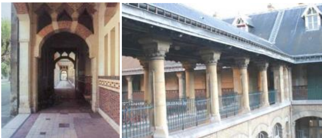
34 e 35 Liceu Lakanal e Liceu Buffon . Galeria exterior.
