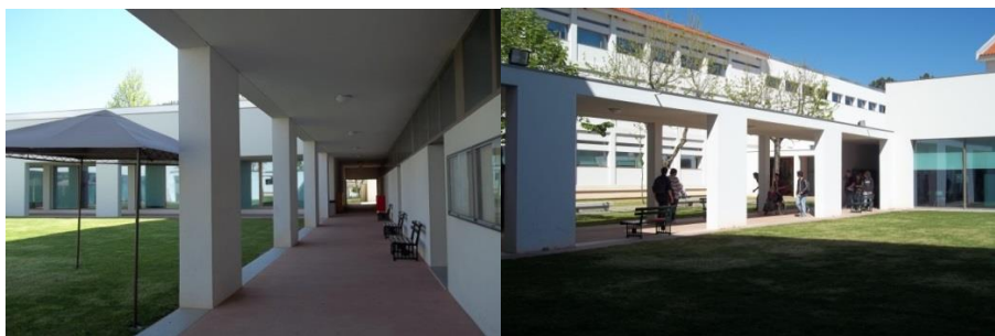
66 e 67 Escola Secundária de Marques de Castilho, Águeda. Galerias exteriores.
