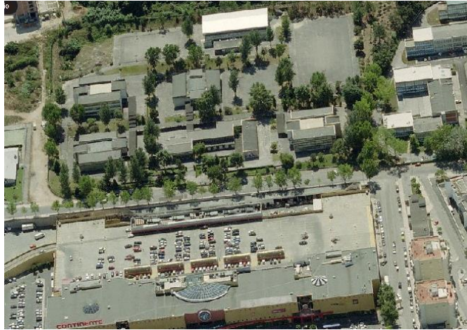
5 Vista aérea da Escola Secundária da Quinta das Flores antes da intervenção de 2008.
