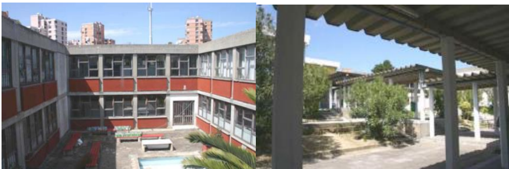
104 e 105 Liceu D. Dinis. Pátio do pavilhão dos laboratórios e espaço exterior.
