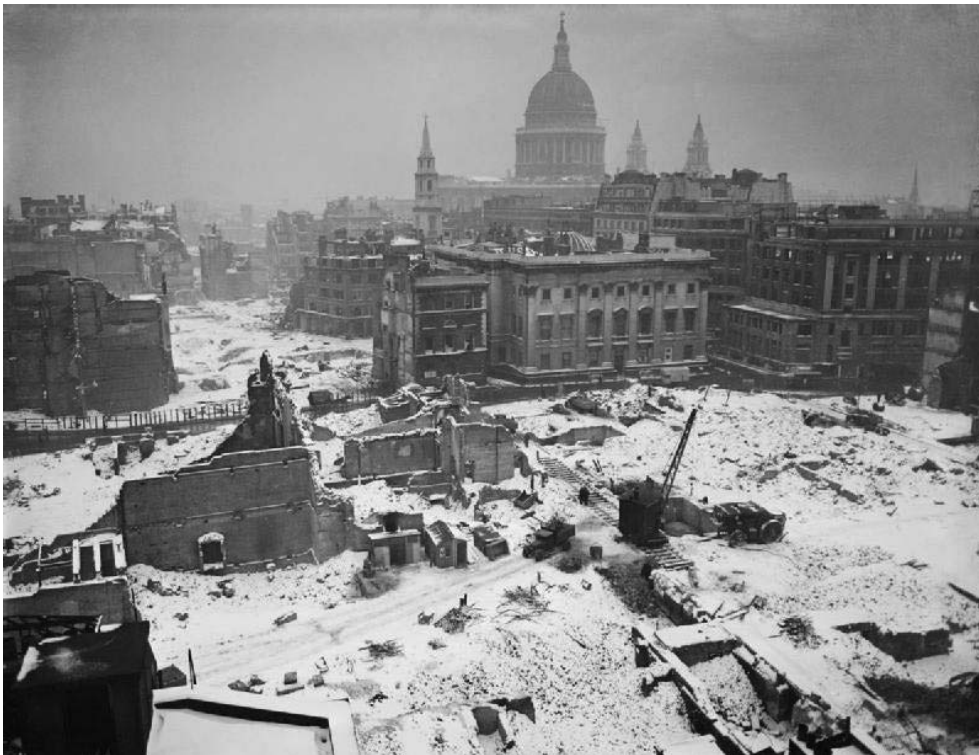
Destruição causada pela 2ª Guerra Mundial na cidade de Londres, Inglaterra.
