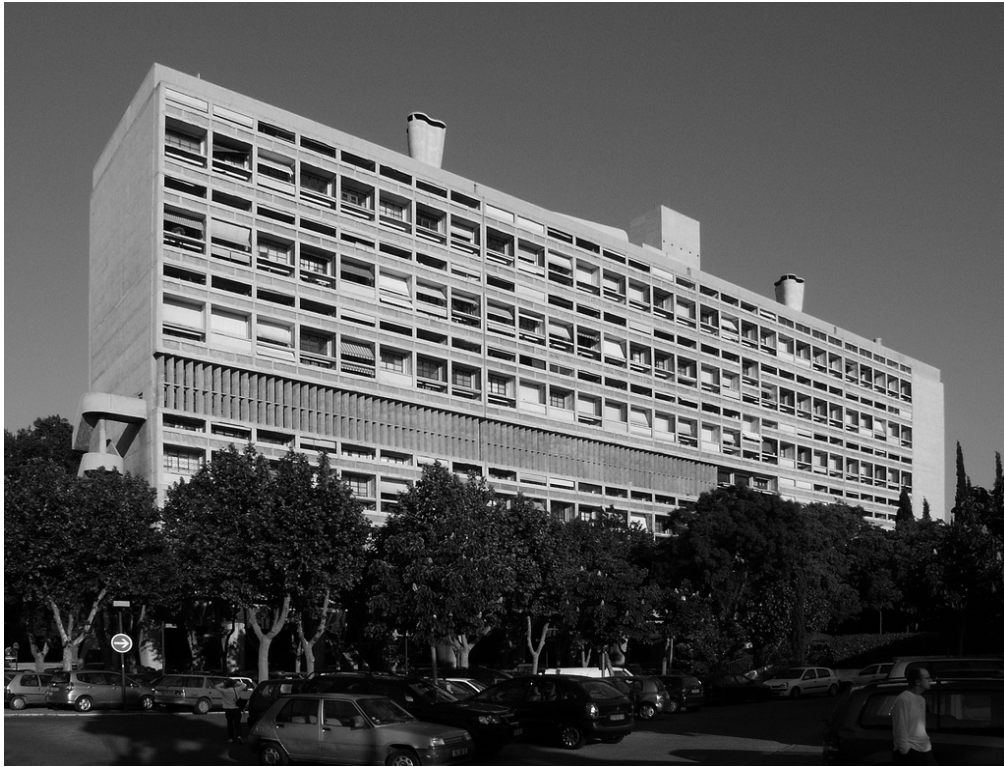
32 | Unité d' Habitation, Marselha, 1947-1953, Le Corbusier.
