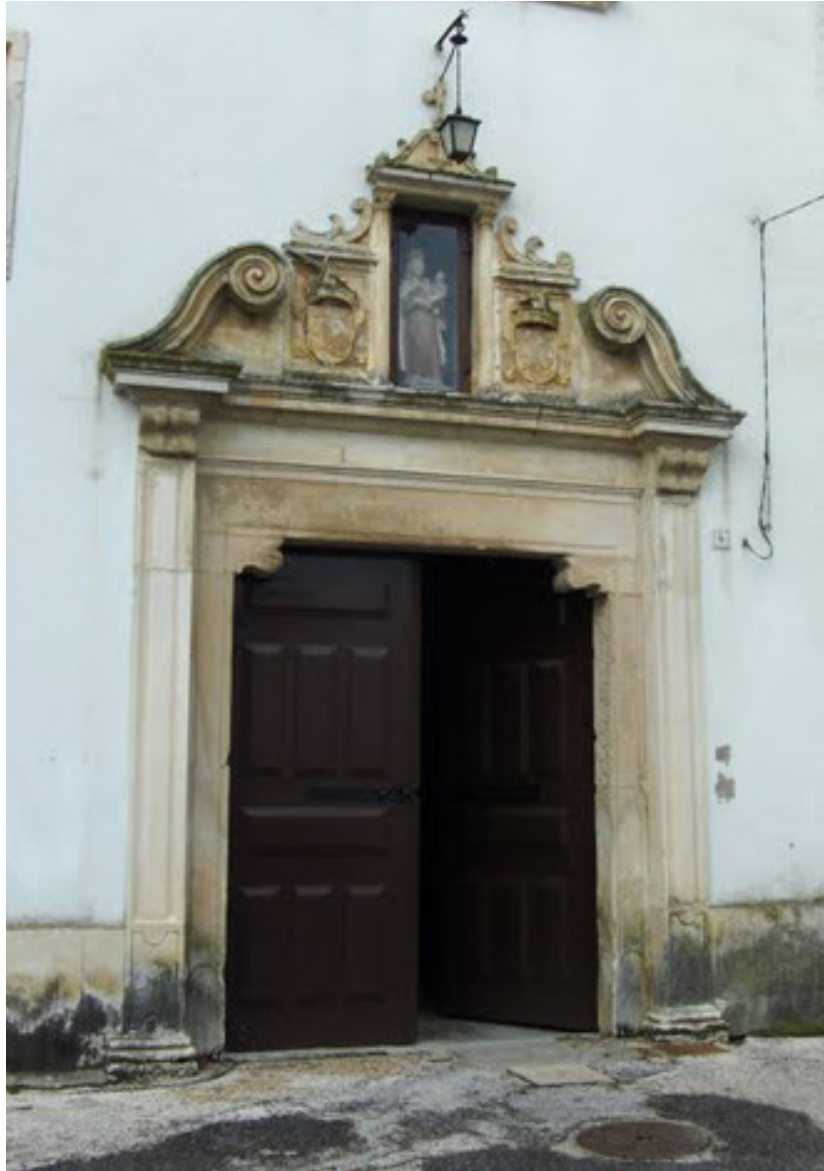
42. Portal de entrada do Convento do Carmo Tentúgal
