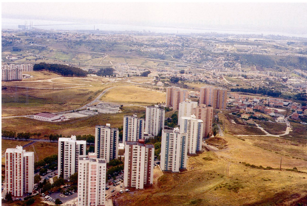
Figura 4 | O território nacional foi sendo pontilhado de construção em toda a sua extensão.
