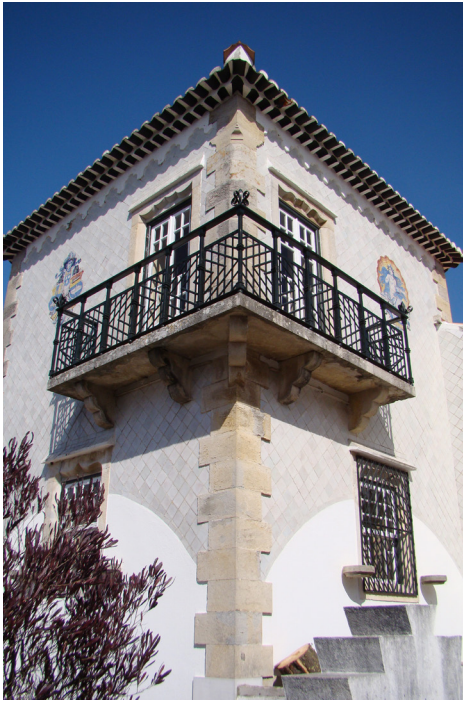
62 - Exterior da Torre
