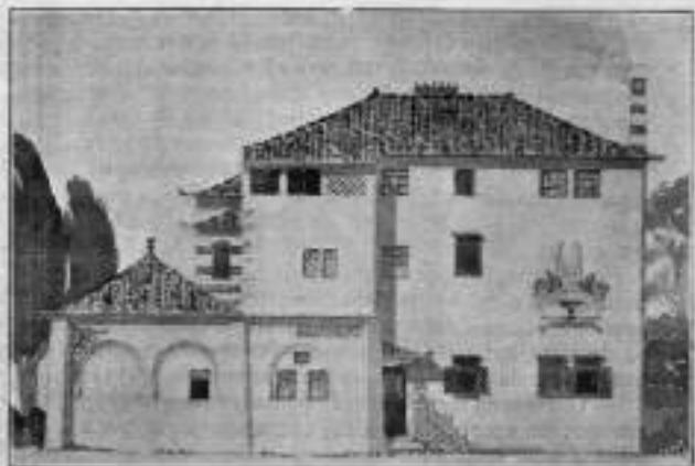
FACHADA LATERAL - NORTE
