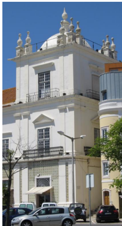
fig. 229 – Torreão do lado nascente
