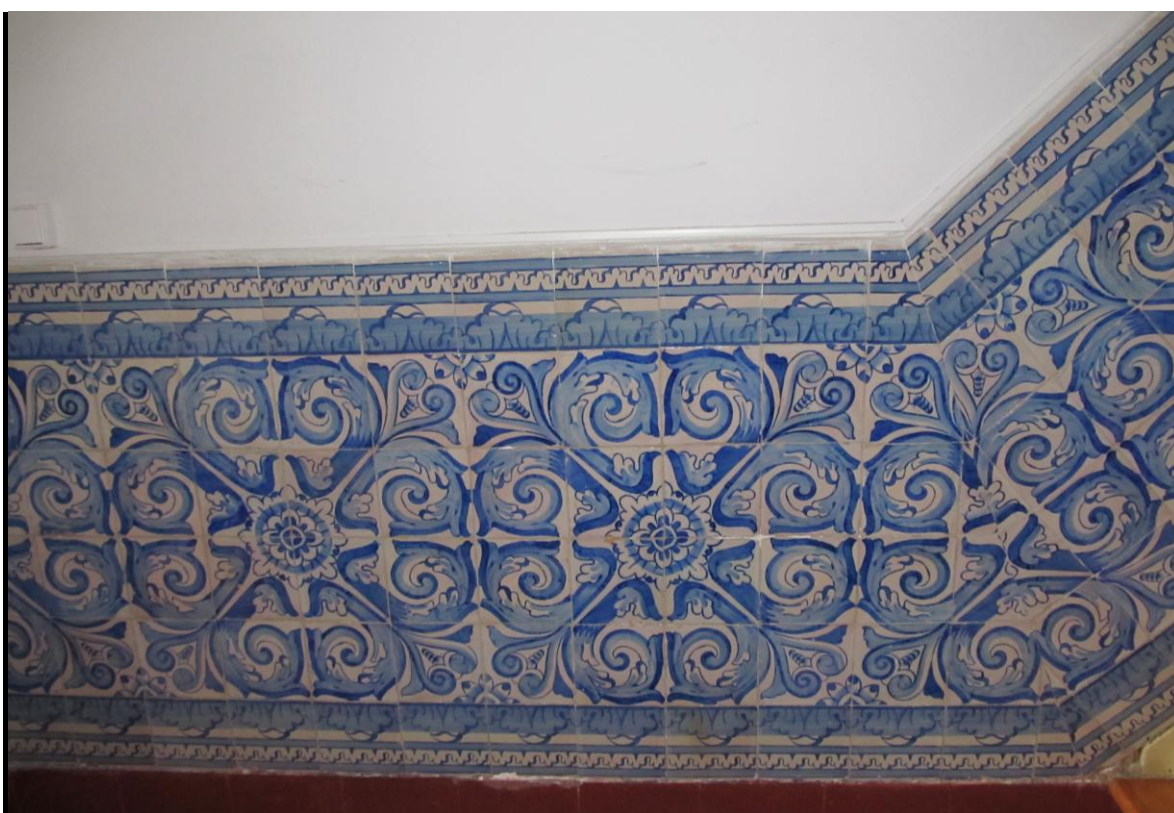
fig. 241 – Silhar de azulejos nas escadas de acesso ao piso superior na ala nascente do edifício
