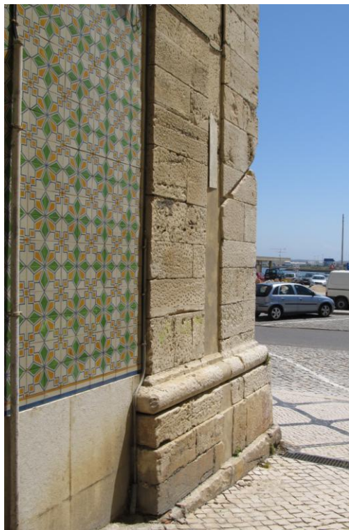
fig. 228 – Pormenor do arranque das pilastras
