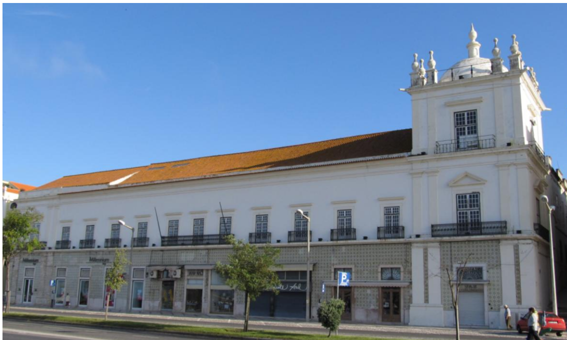
fig. 225 – Fachada sul da Casa do Paço
