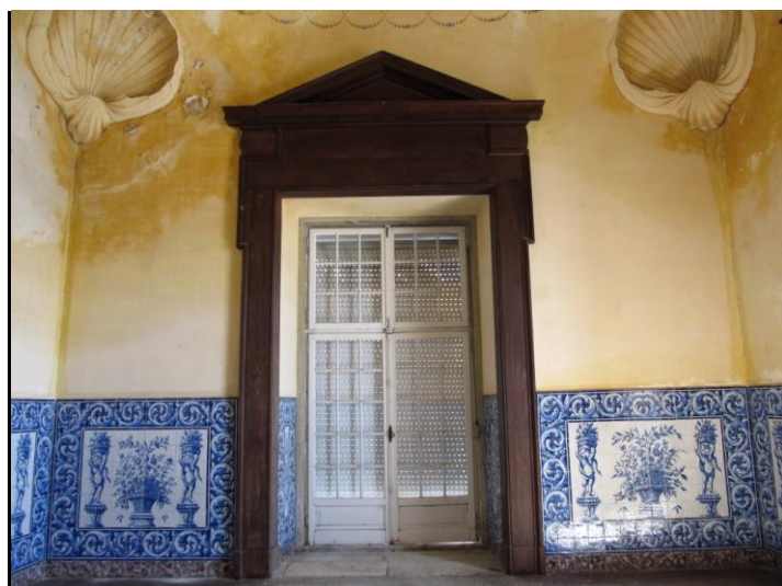
fig. 233 – Interior da sala do torreão
