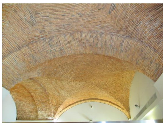
fig. 223 e fig. 224 – Pormenores da abóbada do piso térreo do lado do rio (agência do Millennium BCP)
