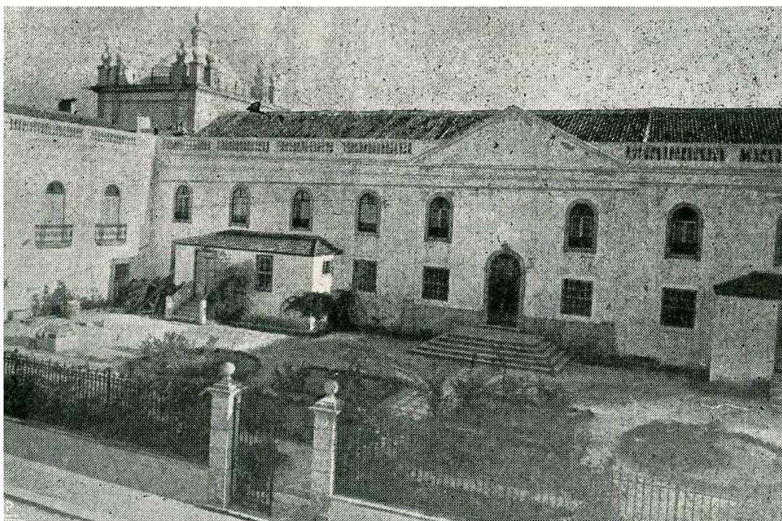
fig. 203 – Fachada norte da Casa do Paço, antes de 1945
