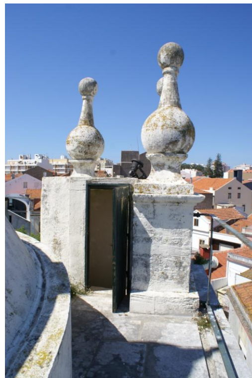
fig. 231 – Acesso à cobertura na base dos pináculos
