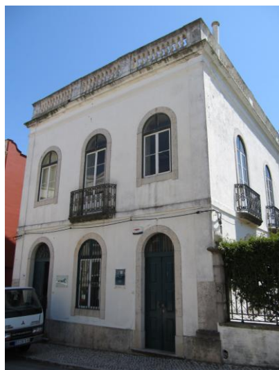
fig. 219 - Fachada norte da ala nascente
