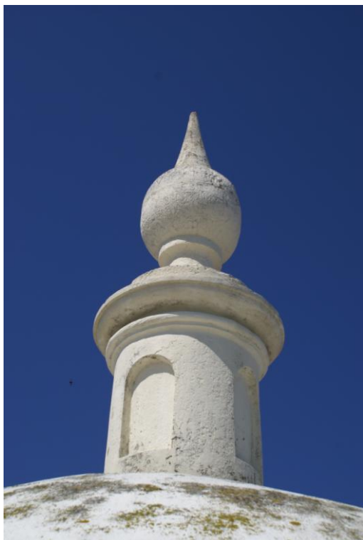
fig. 230 – Falso lanternim e pináculo central do torreão
