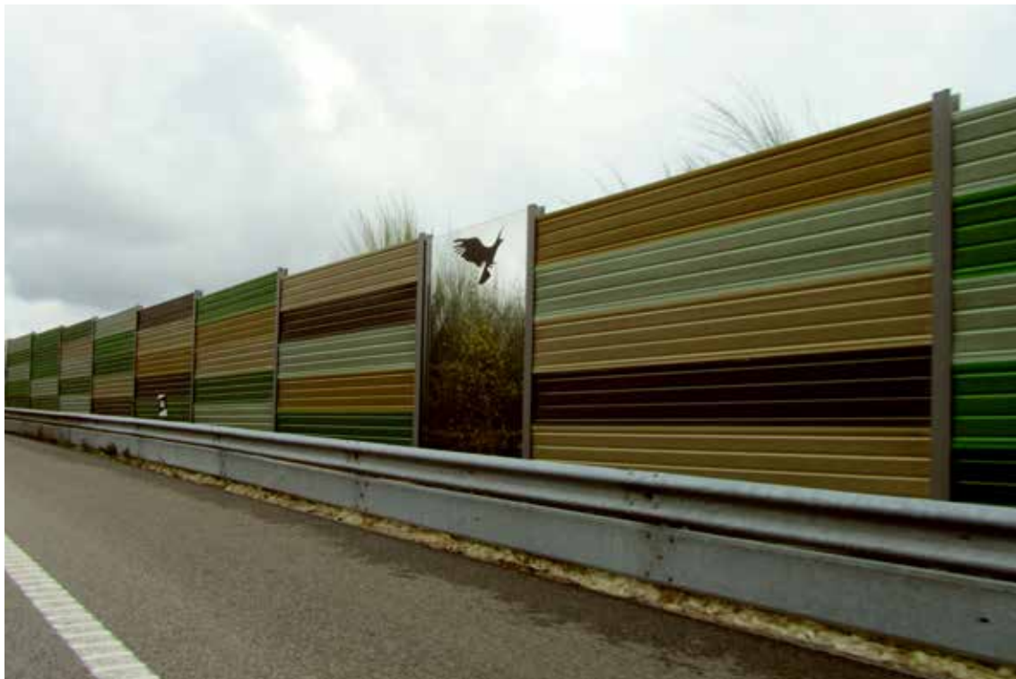
Fig. 234 – Registo fotográfico de Nuno Coelho de barreiras acústicas de auto-estradas.
