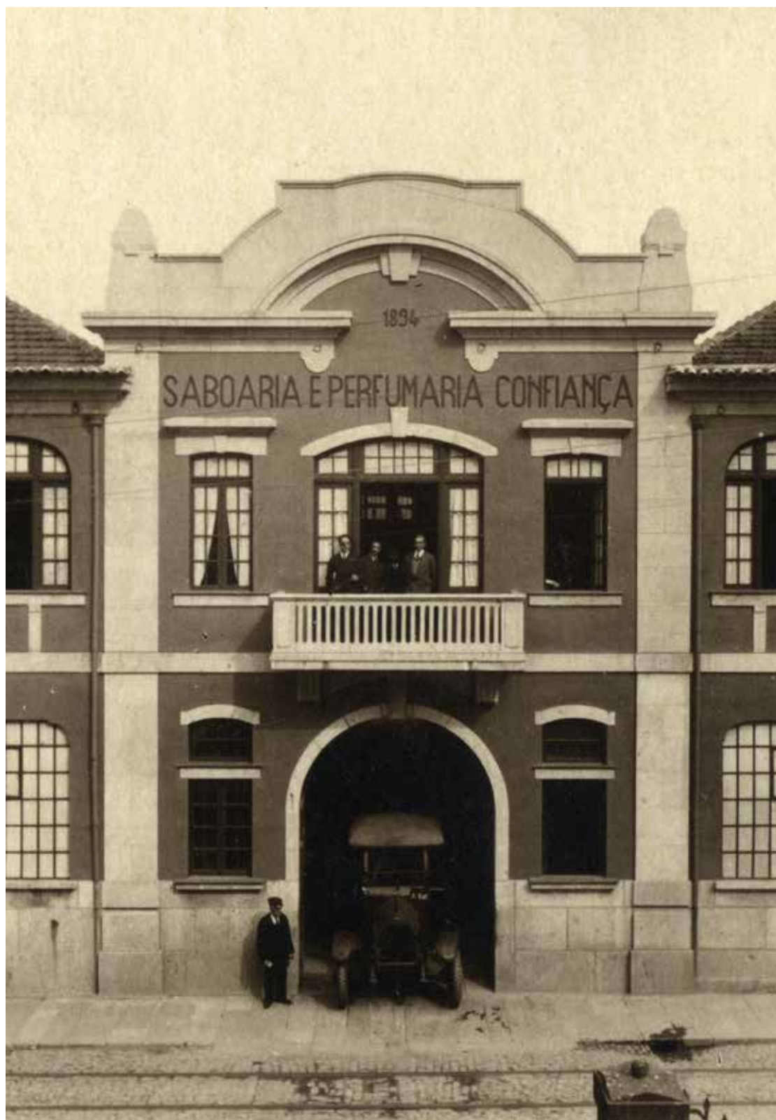
Fig. 22 – Novo edifício da Confiança, circa 1921 (pormenor da Fig. 21).
