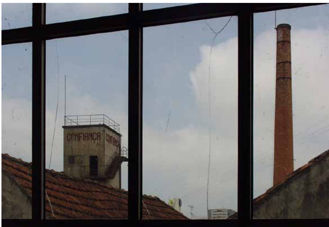
Fig. 51 – Aspeto da torre e da chaminé da Confiança, em 2004.
