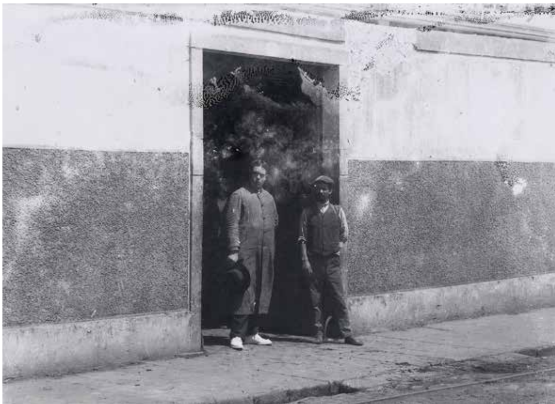
Fig. 13 – Manuel dos Santos Pereira Júnior e operário frente ao edifício da Confiança, em 1913 (fotografia inédita).
