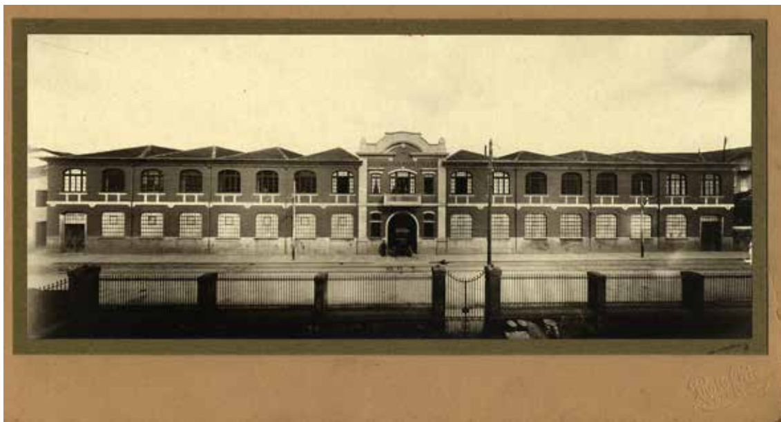
Fig. 21 – Novo edifício da Confiança, circa 1921.
