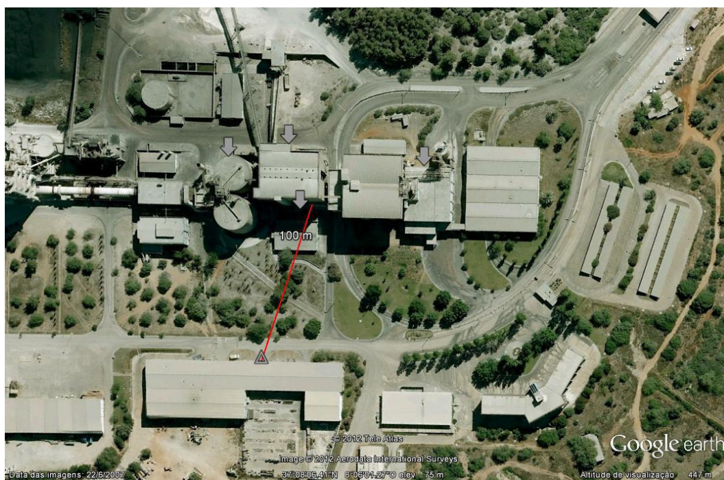
Figura 31 - Fotografia de satélite das instalações da Cimpor em Loulé. São indicados alguns pontos de monitorização (setas), bem como o ponto de instalação do ponto de acesso da rede (triângulo). Fonte: Google, 2007.
