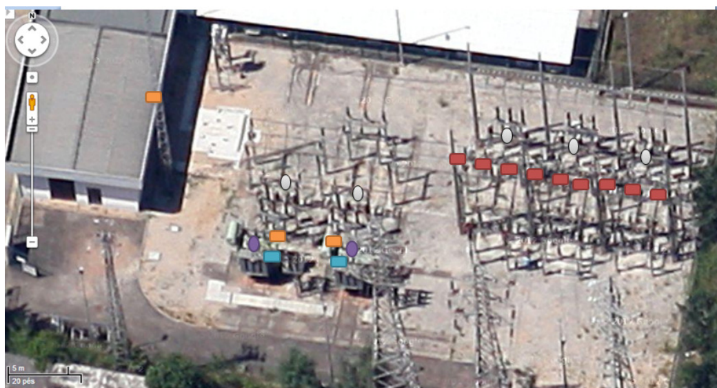
Figura 124 - Imagem de satélite com identificação dos dispositivos instalados na subestação eléctrica do Alto de S. João, em Coimbra. Fonte: Google, 2012.
