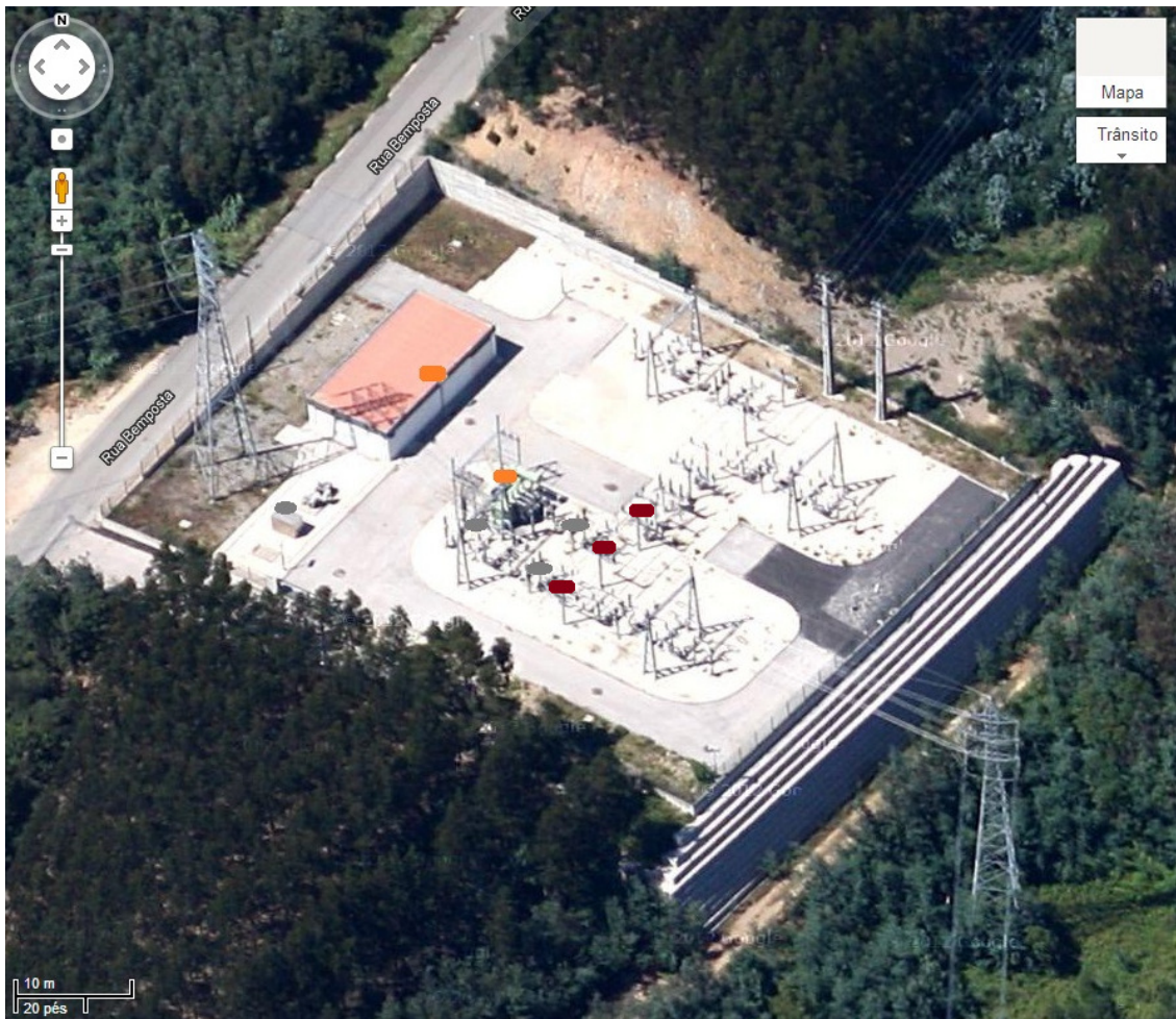
Figura 130 - Imagem de satélite com identificação dos dispositivos instalados (ver Figura com estrutura da rede instalada em Corrente, em Coimbra). Escala apresentada. Fonte: Google, Inc.
