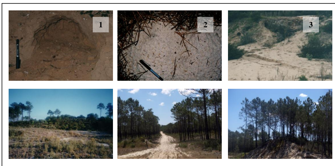
Figura II. 43 – Dunas interiores e processos erosivos identificados; 1 – Desabamentos; 2 – Splash ; 3 - Escorrência
