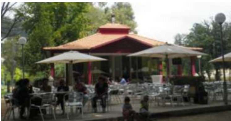
Ilustração 20 – Aspeto atual do chale do parque após reconstrução Foto da autora, 2012.
