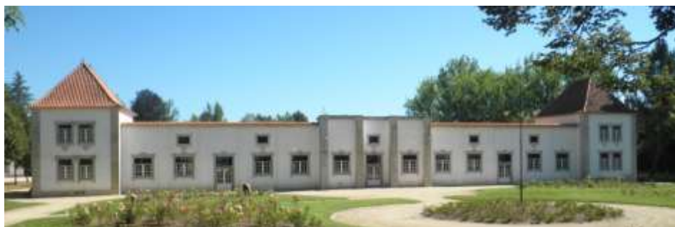
Ilustração 51 – Edifício desenhado por Raul Lino. Foto da autora, 2012.
