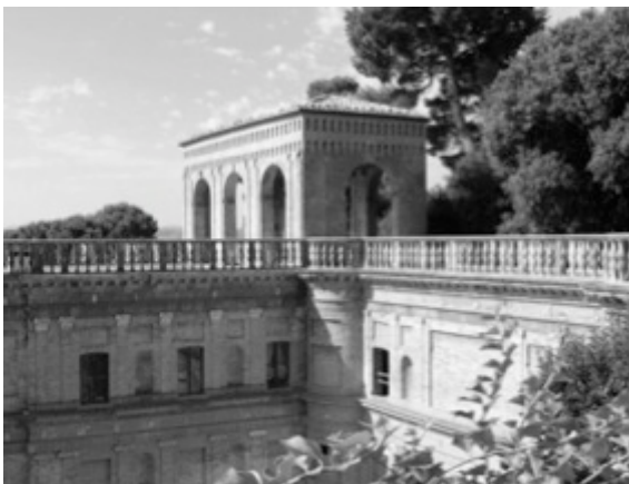
fig. 93 | Ângulos convexos e cobertura da Villa Imperiale, Pésaro
