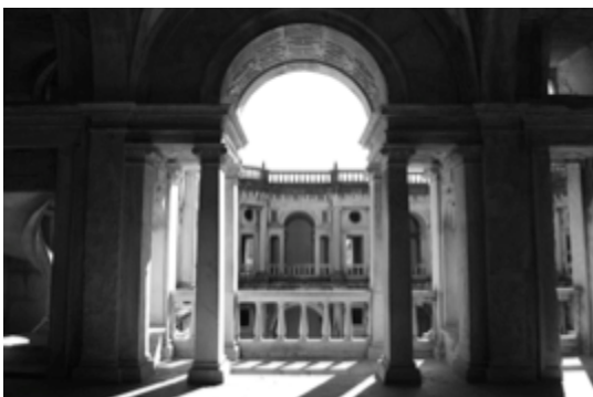
fig. 81 | Serliana na galeria superior do Claustro de D. João III
