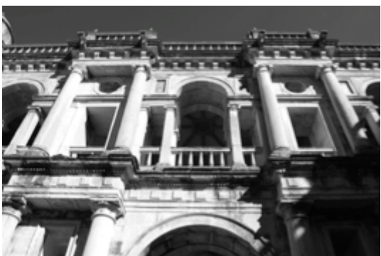
fig. 85 | Serliana na galeria superior do Claustro de D. João III
