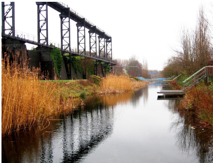
Instalação de perfis de betão no rio Emscher, no início do século passado. Vista do rio Emscher do topo do Gasómetro de Oberhausen. A água é muito importante em vários parques no vale do Ruhr, como o de Duisburg-Nord
