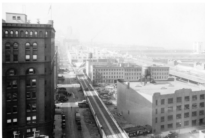
Construção da linha elevada, na Gansevoort Street. St. John's Park Terminal.
