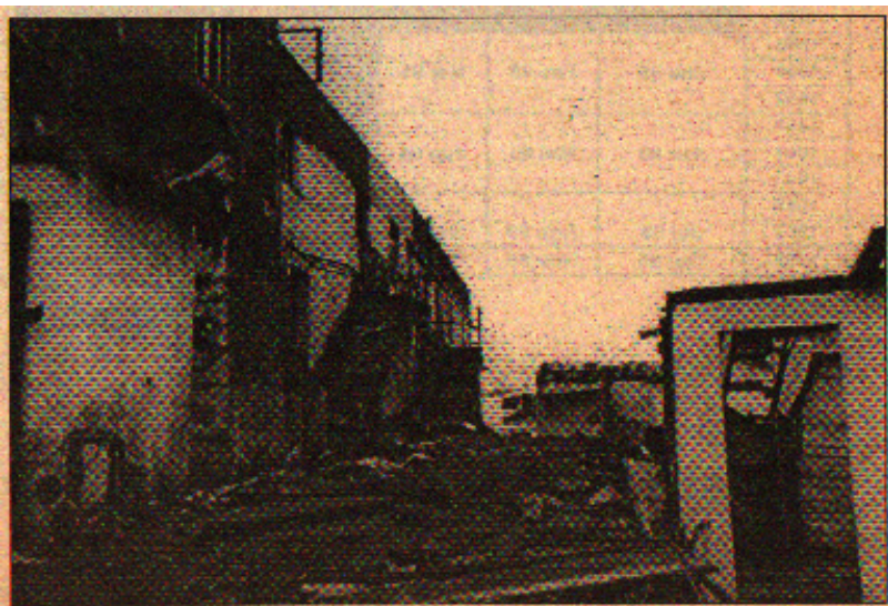
44. Demolição do "Casarão", 1995.
