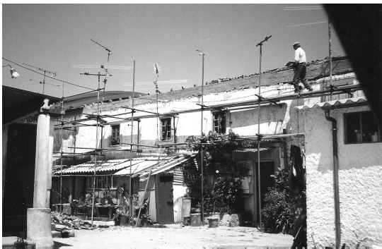
29. Obras no "Casarão".
