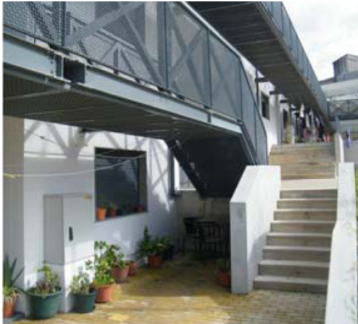
54 a 60. Bairro Municipal da Misericórdia, 2012
