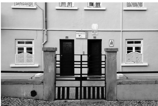
30 e 31. Portas de entrada para o edifício do Colégio, e as traseiras vista de Montes Claros.
