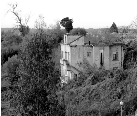
65. "Casa Amarela" na encosta Poente da Conchada.
