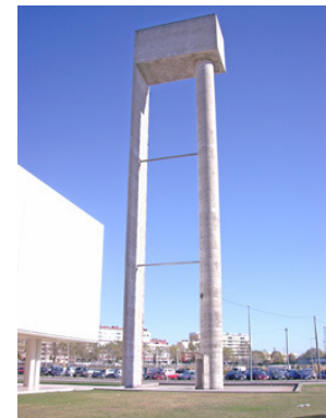
11. Depósito de Água na Universidade de Aveiro, Aveiro, 1991
