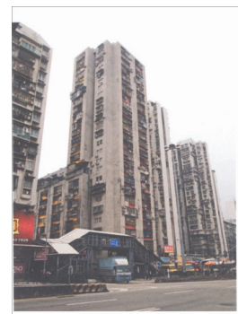
47. Bloco de Habitações para Realojamento, Macau, 1978-84
