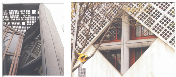
51. Posto Operacional de Bombeiros da Areia Preta. Macau, 1990-98
