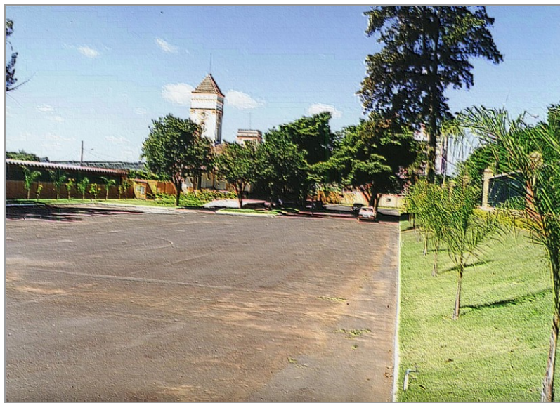
FIGURA 2 - Vista da lateral posterior-esquerda do edifício e pátio
