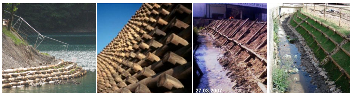
Figura 2.29 – Estabilização de taludes (Verde, 2010; Flach e Frenette, 2000)
