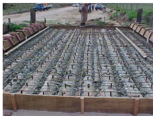
Figura 2.34 – Execução de uma ponte mista madeira-betão (Junior, 2004)
