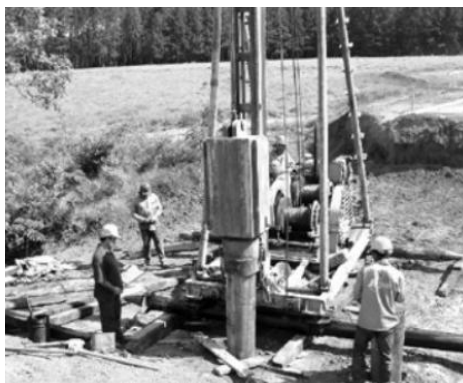
Figura 2.10 – Cravamento de uma estaca de madeira (Miná, 2005)
