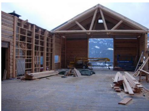
Figura 2.23 – Montagem da cobertura (Malo e Ellingsbo, 2010)
