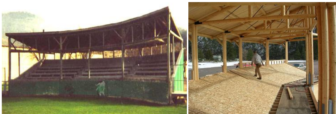
Figura 2.26 – Cobertura de uma bancada (Engineers, 2010)
