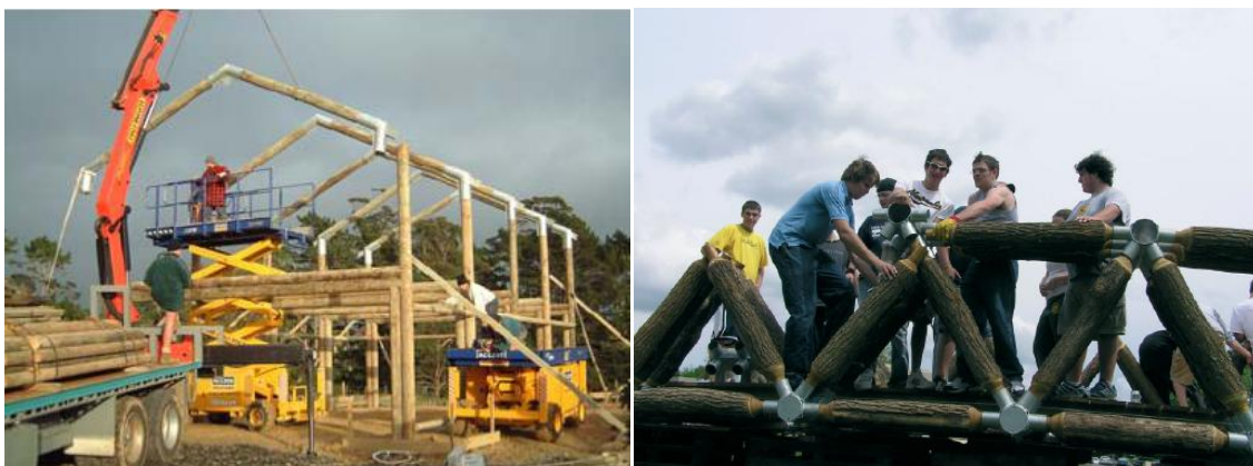
Figura 6.8 – Ligações de chapas externas tubulares (Morris et al. , 2008; Al-Khattat, 2002)
