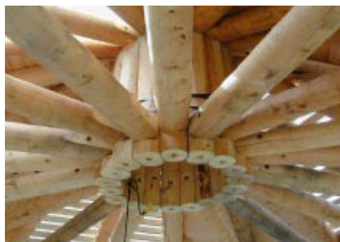
Figura 2.18 – Ligações usadas no telhado da estrutura (Levan, 2000)
