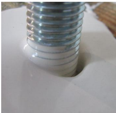
Figura 6.54 – Defeito de execução numa ligação de varões colados
