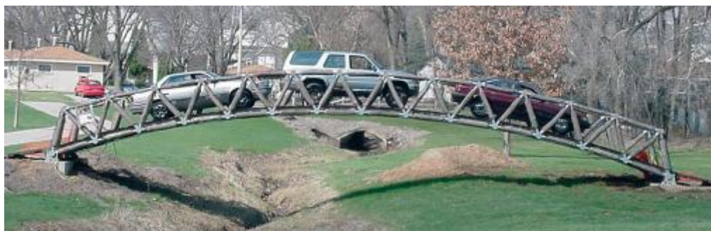
Figura 2.32 – Ponte treliçada (Al-Khattat, 2008)
