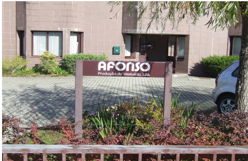
Pátio da Fábrica Afonso
