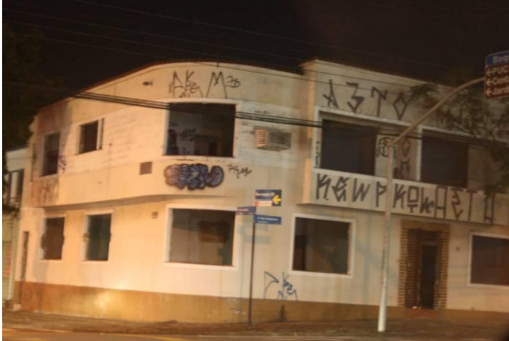
Fig 7. Casa pichada na região do Rebouças em Curitiba.
