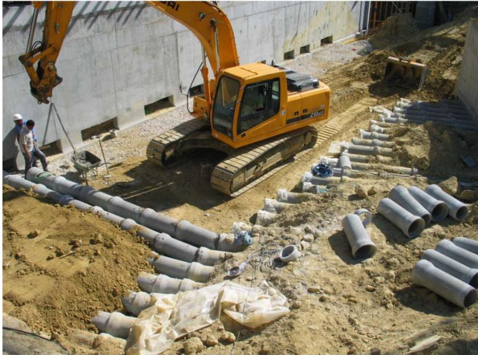
Fig. 21 - Instalação de tubos para arrefecimento pelo solo - Edifício Solar XXI
