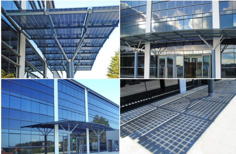
Fig. 16 - Câmara Municipal de Proença-a-Nova - Potência Instalada: 7 kw Área: 67 m<sup>2</sup>
