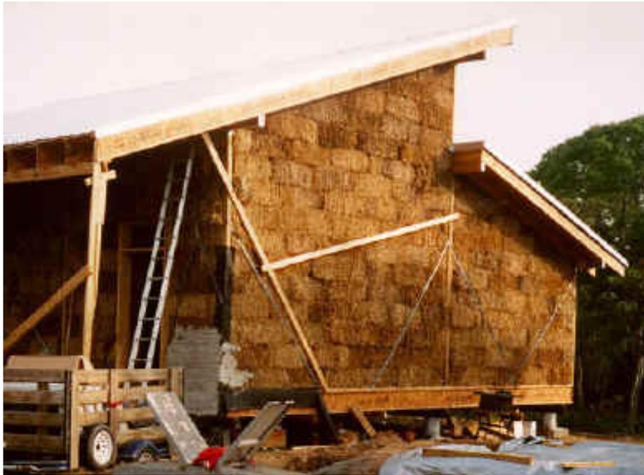
Fig. 27 - Construção com fardos de palha
