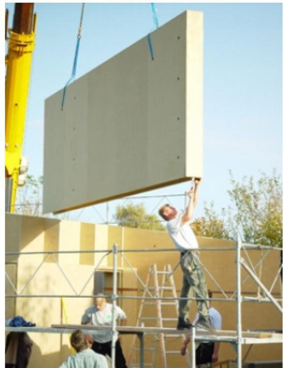
Fig. 30 – Palha Prensada, fase de construção
