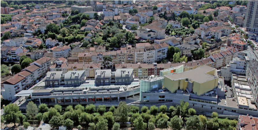
Figura 100 Vista aérea do Fórum Visu
