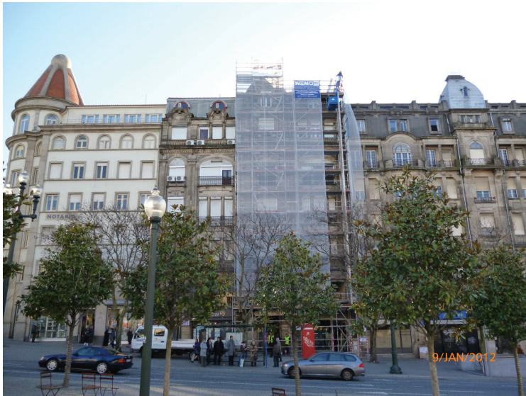
Figura 33 Restauro de um edifício na Avenida dos Aliados, no Porto
