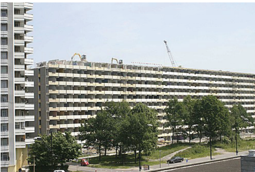
Figura 126 Início das demolições
