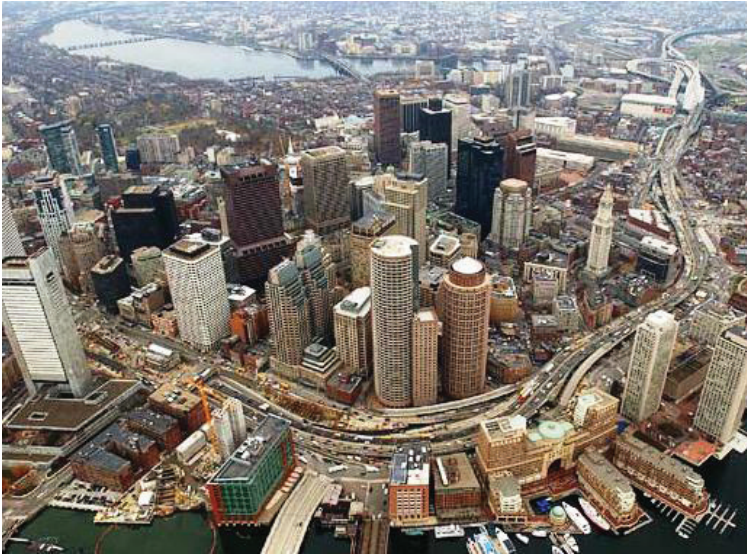
Figura 113 A Central Artery de Bóston, antes das obras
