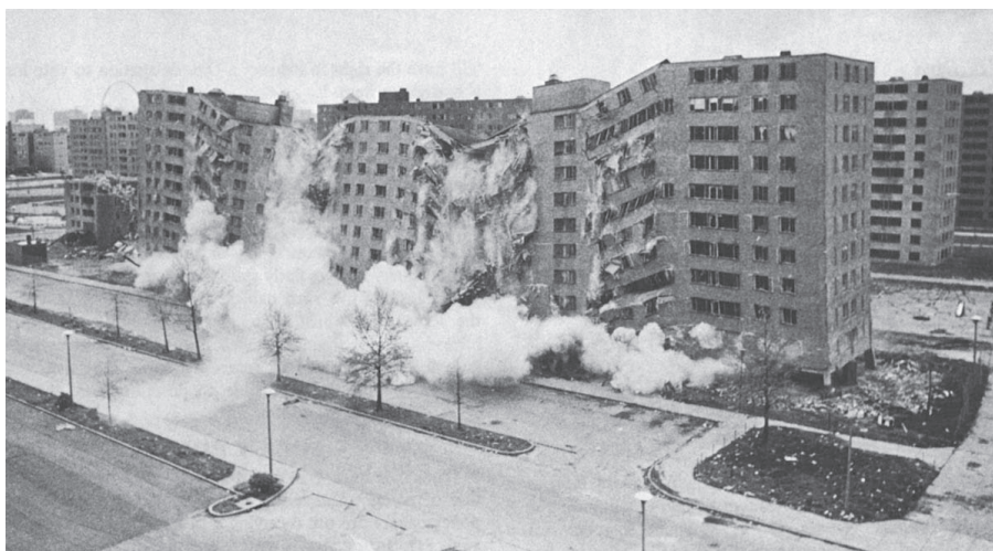
Figura 17 Demolição do complexo residencial Pruitt-Igoe , em Saint Louis
