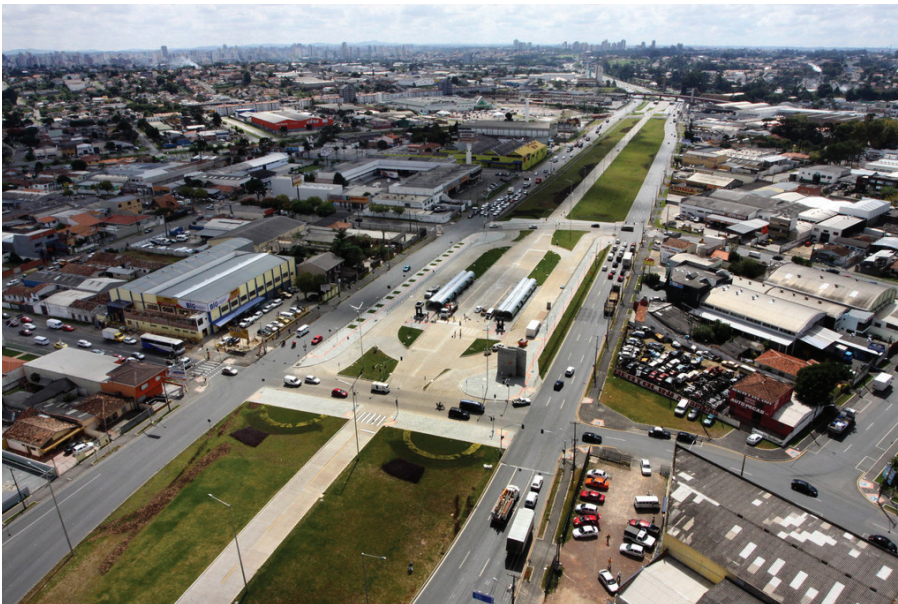
Figura 70 Curitiba: Linha Verde, depois das obras
