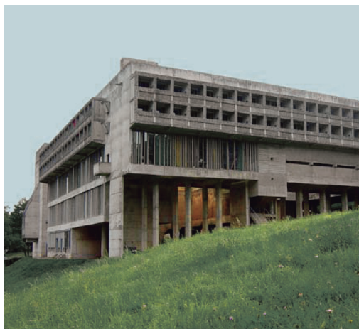
Fig.83 - Pilotis que sustentam o Convento
