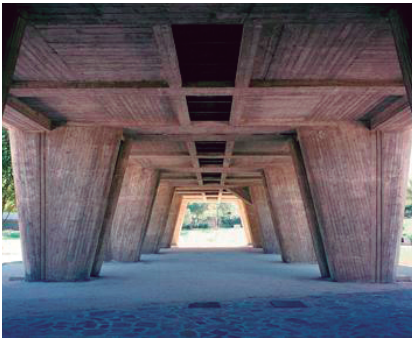
Fig.75 - Pilares de betão que suportam o edifício
