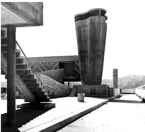
Fig.73 - Vista da cobertura
