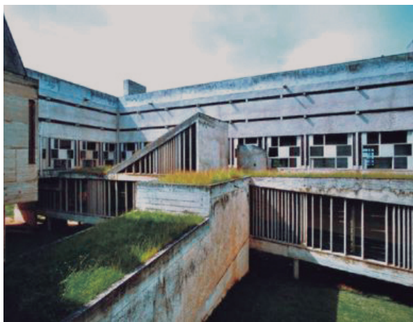
Fig.89- Claustro com as rampas e o átrio cobertos
