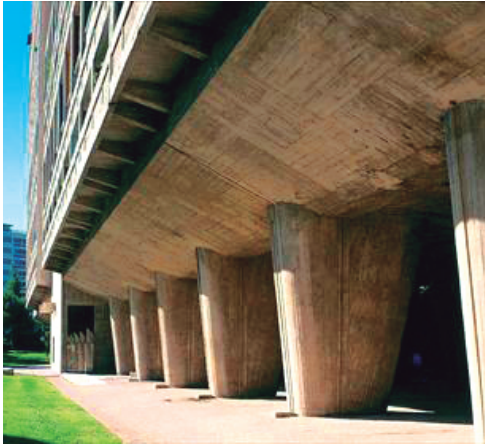
Fig.79 - Estrutura de betão da Unidade de Habitação de Marselha
