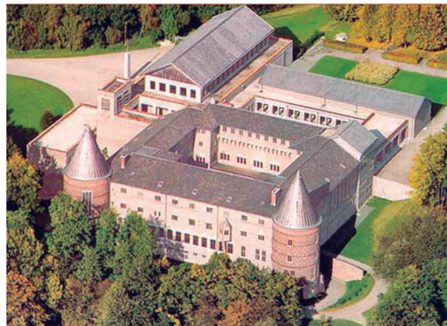
Fig.115 - Vista geral da Abadia de Vaals
