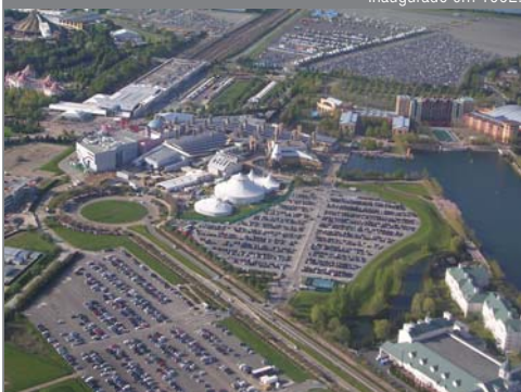
22 Disneyland Resort Paris: parques de estacionamento e estação ferroviária Marne-la-Vallée-Chessy.
