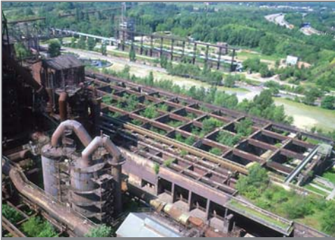
118 Parque-galeria do grande Bunker, Duisburg-Nord.
