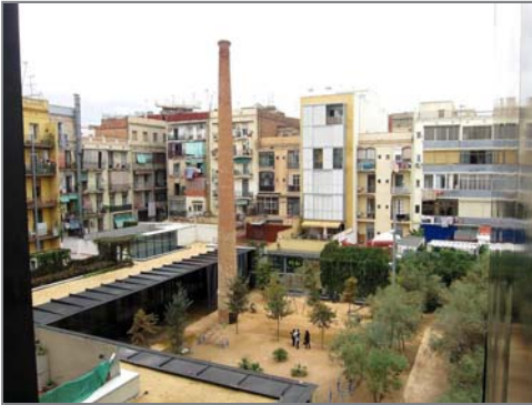
61 Vista do interior da Manzana depois da intervenção.
