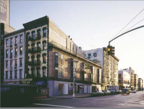
92 Vista exterior da galeria de arte e arquitectura Storefront, Nova Iorque.
