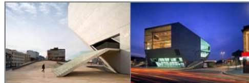
105 106 Vistas do exterior, Casa da Música, Porto.
