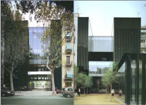
63 64 Vistas do acesso desde o exterior e interior da Manzana.
