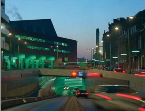
99 Vista do túnel, interface intermodal de Leuven, Bélgica.
