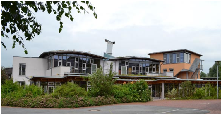
Fig. 62 - Vista da cantina e "casa" principal
