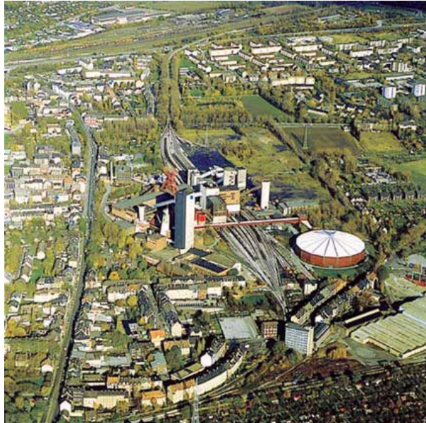
Fig. 48 - Vista aérea da mina e da zona envolvente de Bismarck antes do encerramento em 1995.
