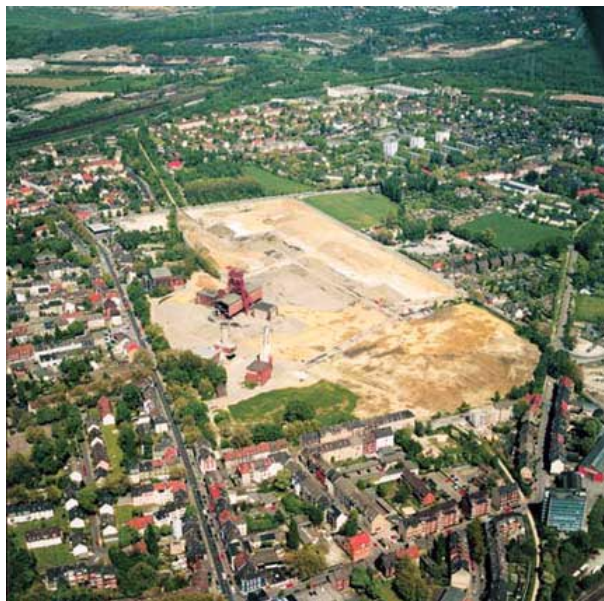
Fig. 49 - Vista aérea da mina depois da demolição.
