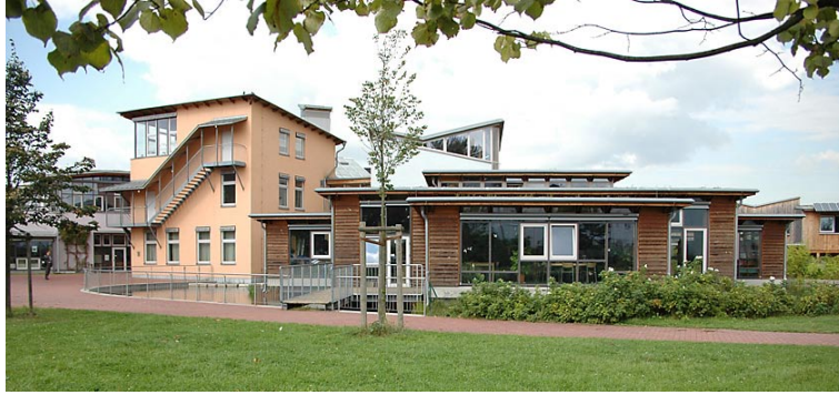
Fig. 61 - Vista da entrada principal
