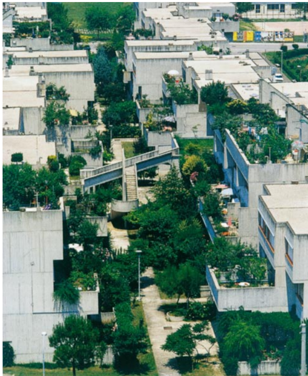
Fig. 27 - Villaggio Matteotti em Terni, Giancarlo De Carlo
