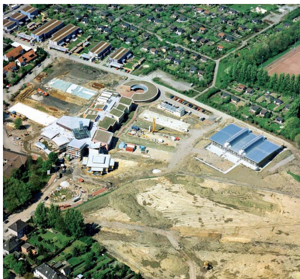
Fig. 51 - Vista aérea da escola na fase inicial da construção, 1999
