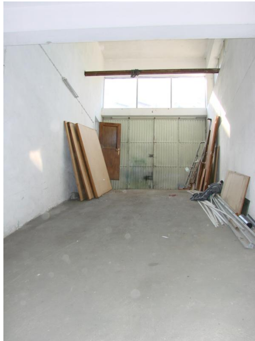
Rampa de acesso ao estacionamento
