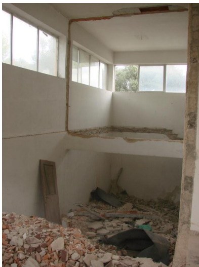
Anulação da rampa.
