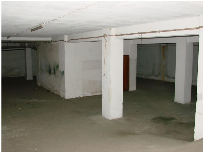
Antigo estacionamento do prédio
