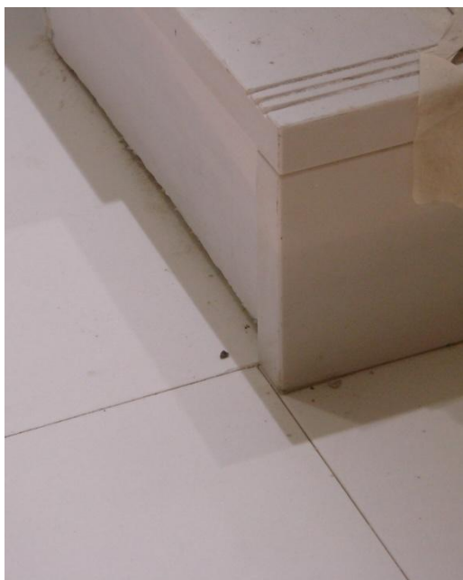
Pormenor do encontro de placas de Silestone , em articulação com o degrau
