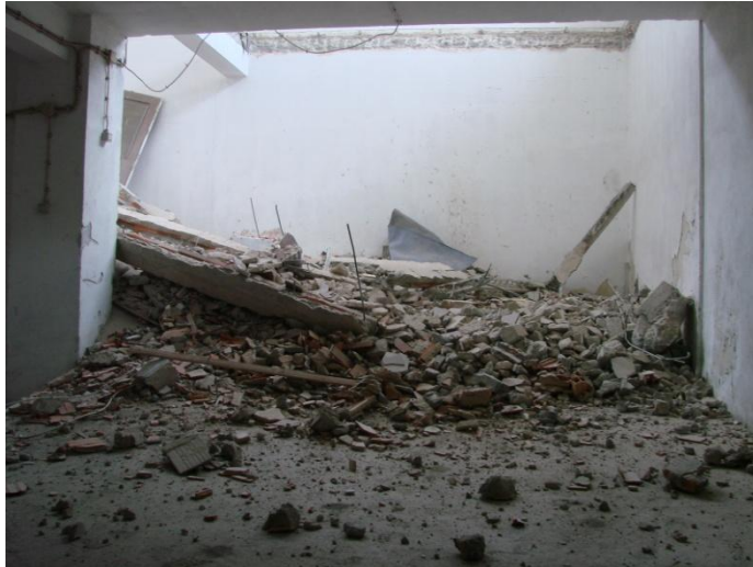
Demolição de laje captando luz para o piso -1 (onde se implantaria a escada).
