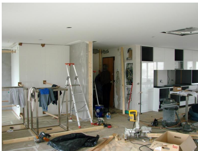
Fotografias captadas durante o acompanhamento da obra
