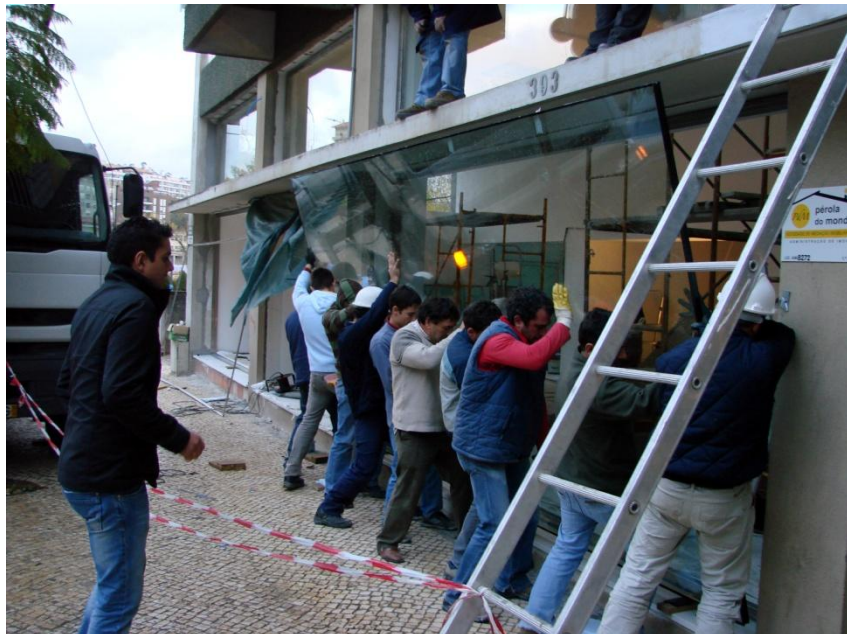
Colocação de vidro duplo laminado referente ao vão 1 (5 x 2.30 m)
