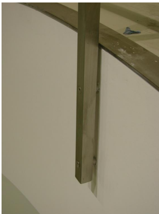
Pormenor de fixação de uma guarda
