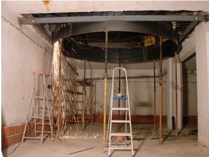
Fotografia captada durante o acompanhamento da obra: soldagem de uma estrutura metálica.
