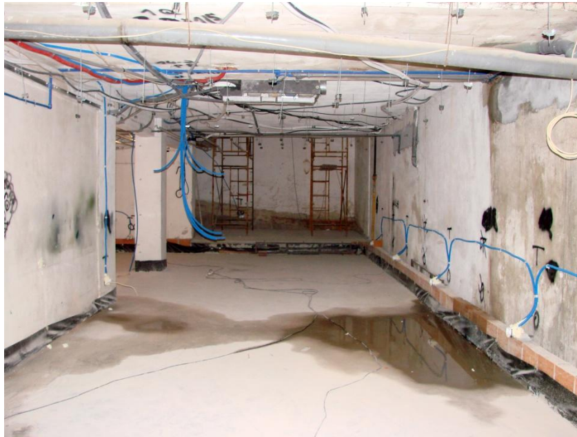
Correcção de algumas marcação efectuadas pelo electricista
