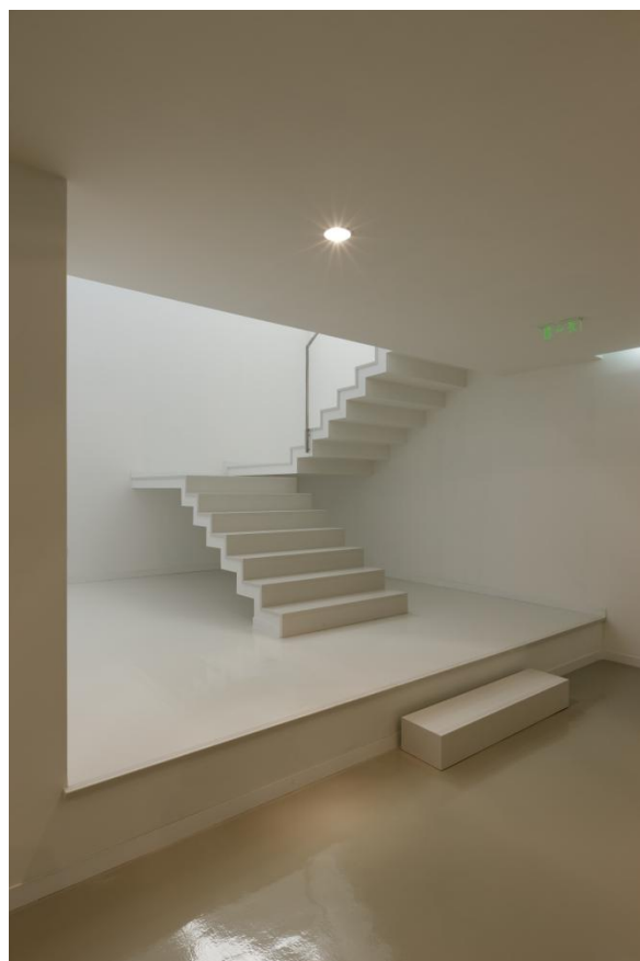
Escadas (de acesso ao piso -1), patamar e degrau de chamada em Silestone [LFA]
