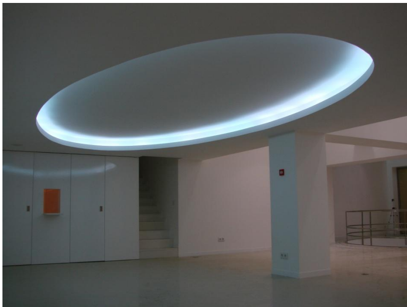
Fotografia captada durante o acompanhamento da obra: ensaio de iluminação através de sanca.
