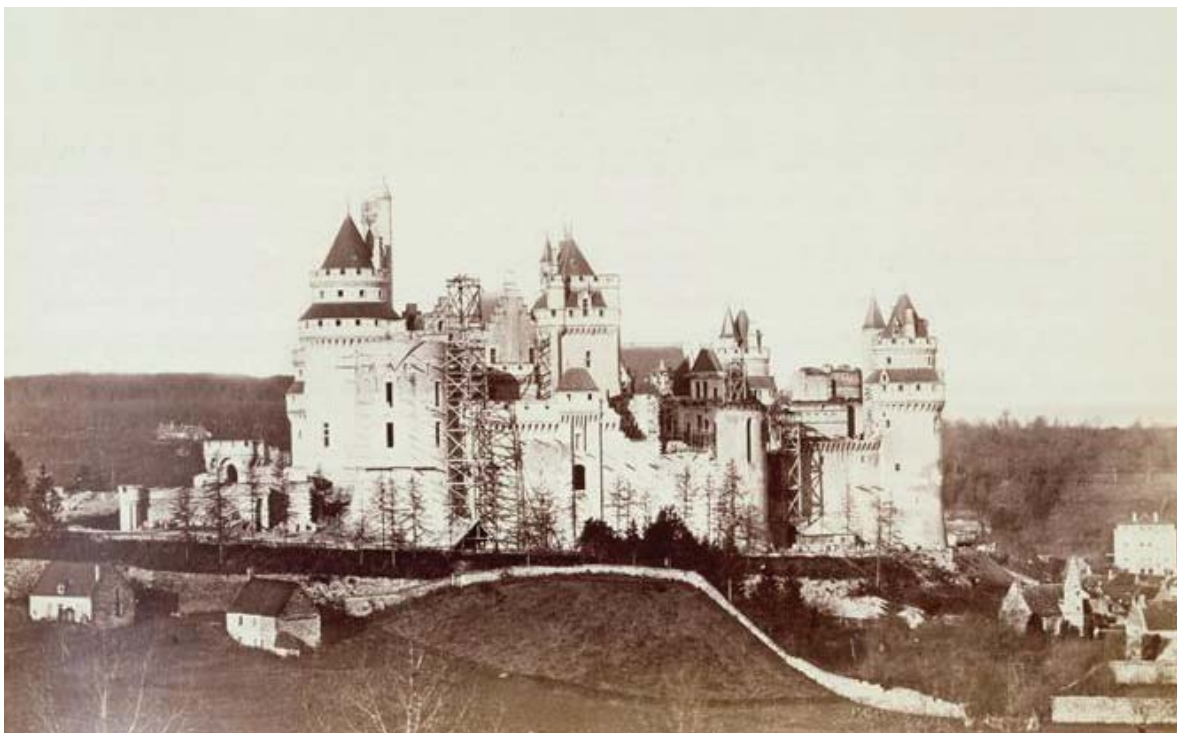
15. Recuperação do Castelo Imperial de Pierrefonds, por Viollet-le-Duc (Pierrefonds, França, 1867) f. Chevallier Auguste
