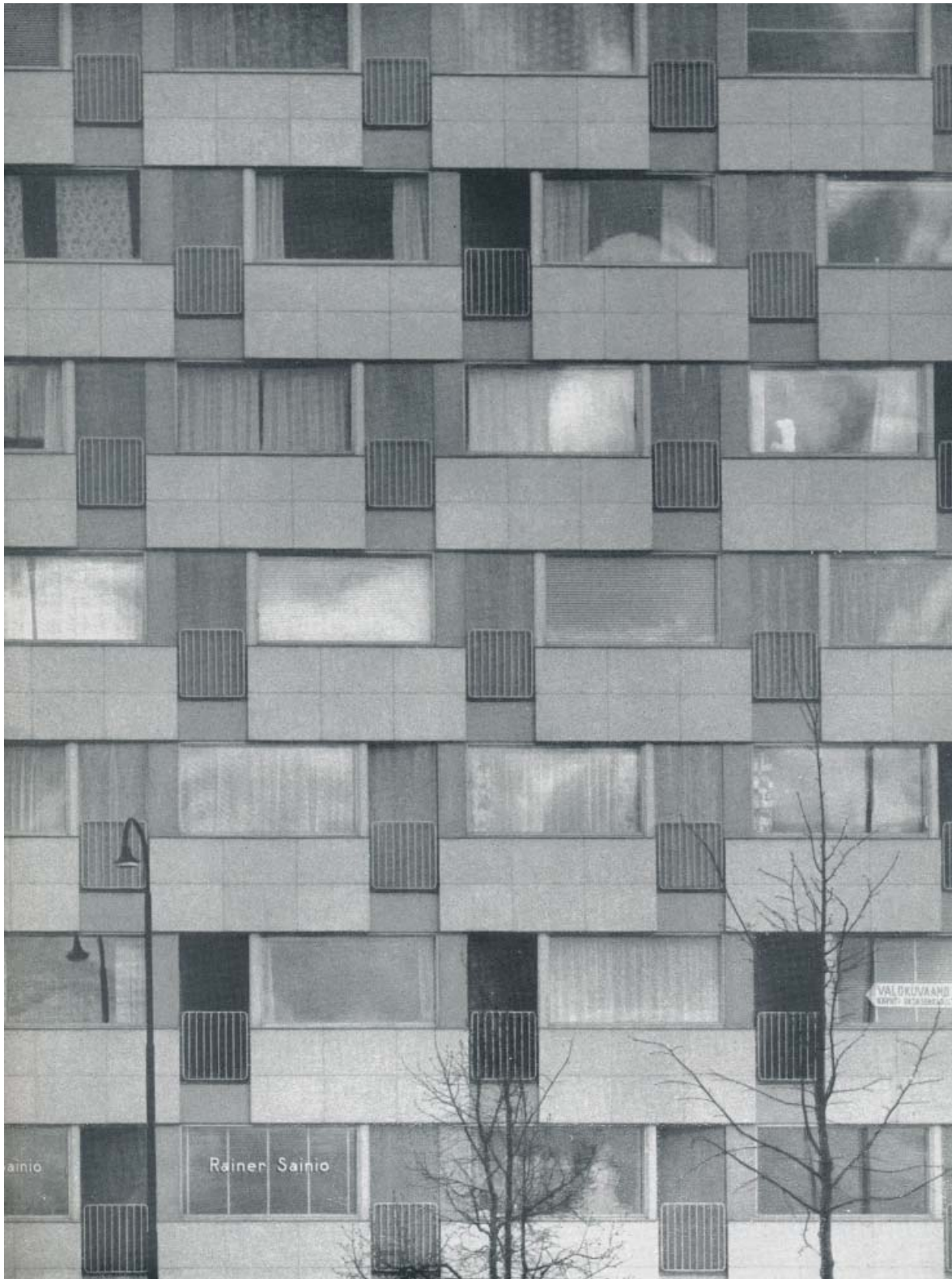
31. Edifício de apartamentos (Lappeenranta, Finlândia, [s.d.]) f. Eric de Maré a. Olli Kivinen
