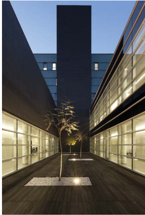
75. Hospital Privado de Guimarães (Guimarães, Portugal, 2009) f. Luís Ferreira Alves a. Pitágoras Arquitectos
