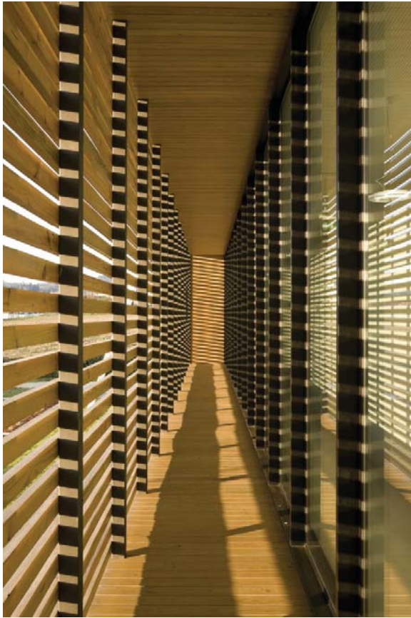
74. Piscinas de Ribeirão (Vila Nova de Famalicão, Portugal, 2008) f. Luís Ferreira Alves a. Pitágoras Arquitectos
