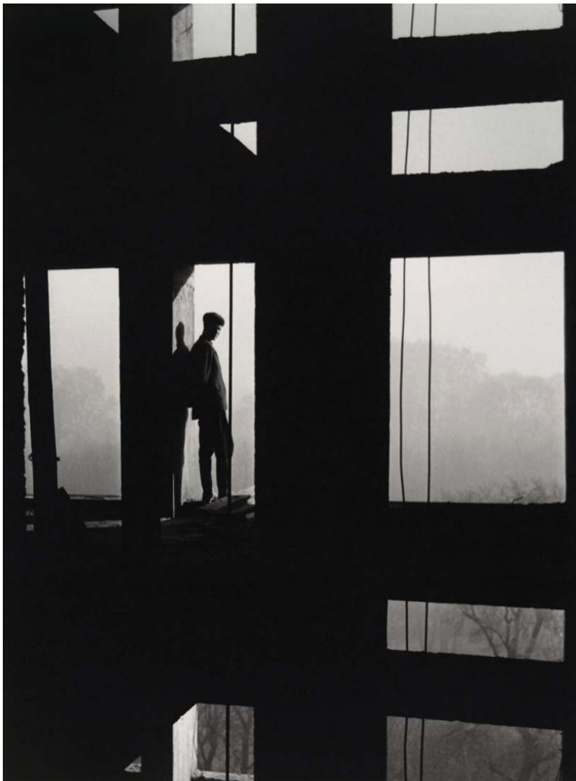
33. Unidade de Habitação de Marselha (Marselha, França, 1949) f. Lucien Hervé a. Le Corbusier
