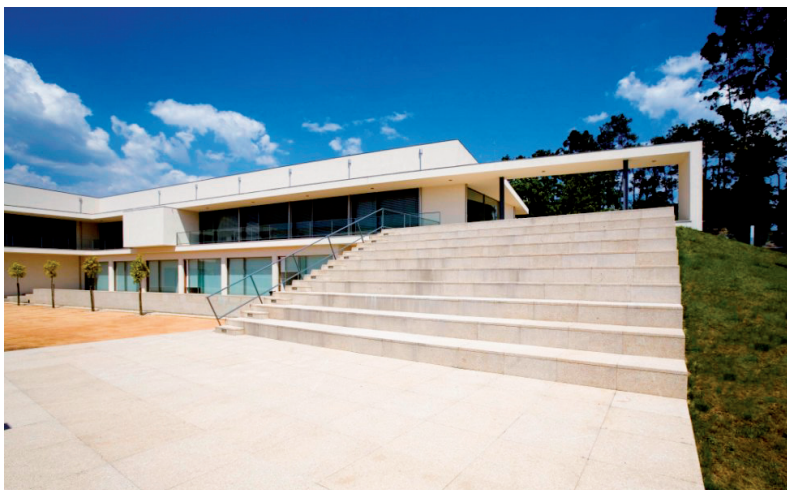
Fig. 155 - Pátio interior da biblioteca
