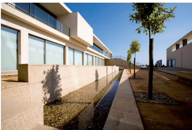
Fig. 159 - Pátio interior da biblioteca
