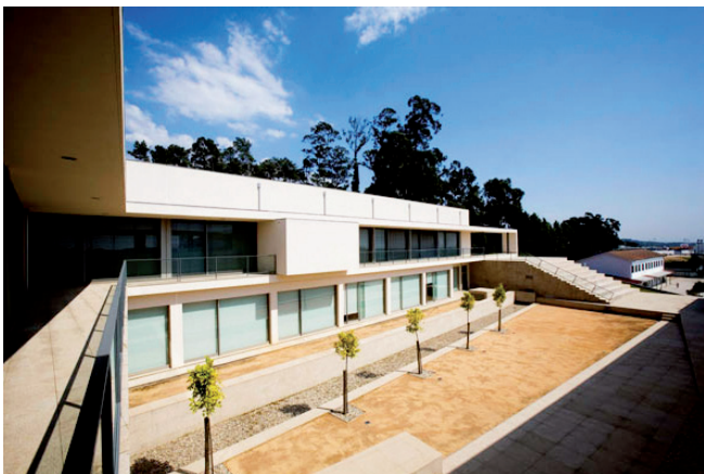
Fig. 158 - Pátio interior da biblioteca
