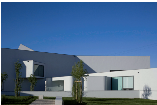
Fig. 93 - Vista Nascente da Biblioteca Municipal de Ílhavo
