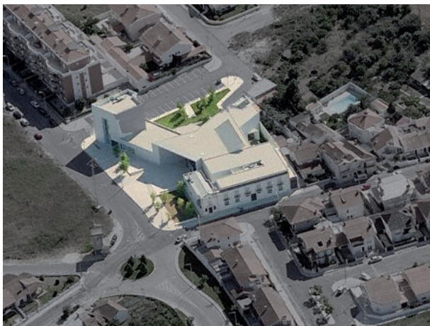
Fig. 94 - Fotografia aérea da Biblioteca Municipal de Ílhavo, de Poente
