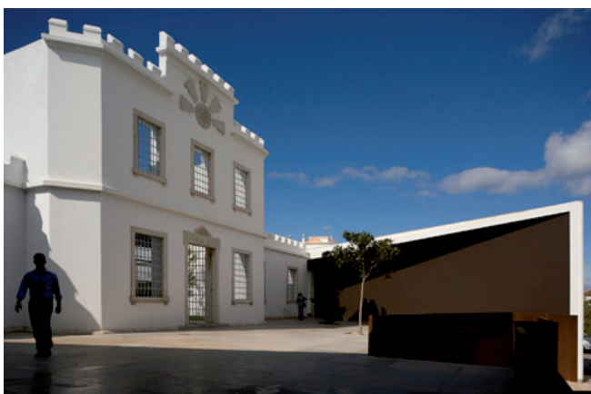
Fig. 63 - Pátio a uma cota mais alta que a da rua, precedendo a entrada
