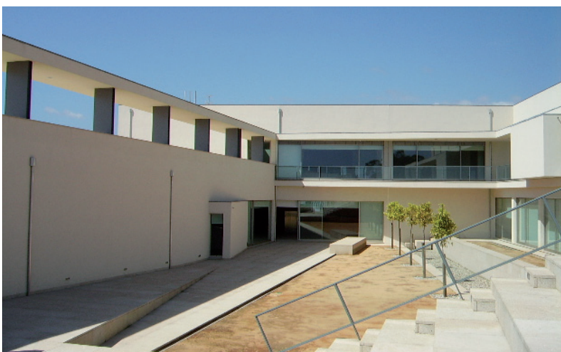
Fig. 154 - Pátio interior da biblioteca
