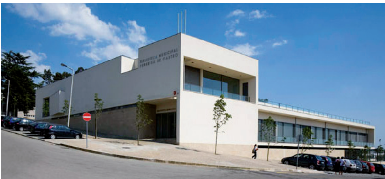
Fig. 152 - Biblioteca Municipal Ferreira de Castro
