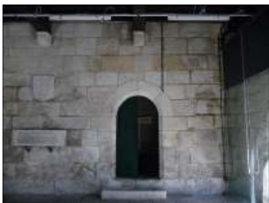
Fig. 31 - Vista de porta de acesso a arrumo (debaixo das escadas exteriores)
