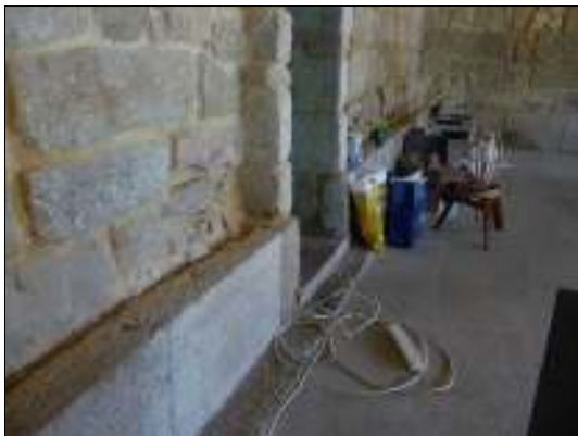
Fig. 14 - Murete corrido na parede interior norte
