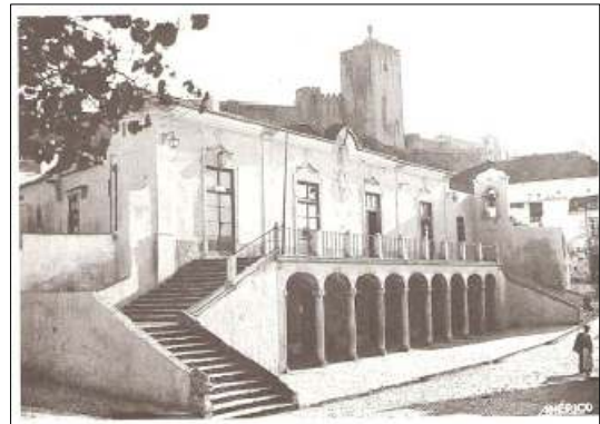
Fig. 87 - Casa da Câmara de Palmela
