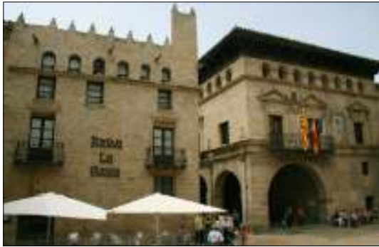
Fig. 79 - Ayuntamiento de Valderrobres, Espanha
