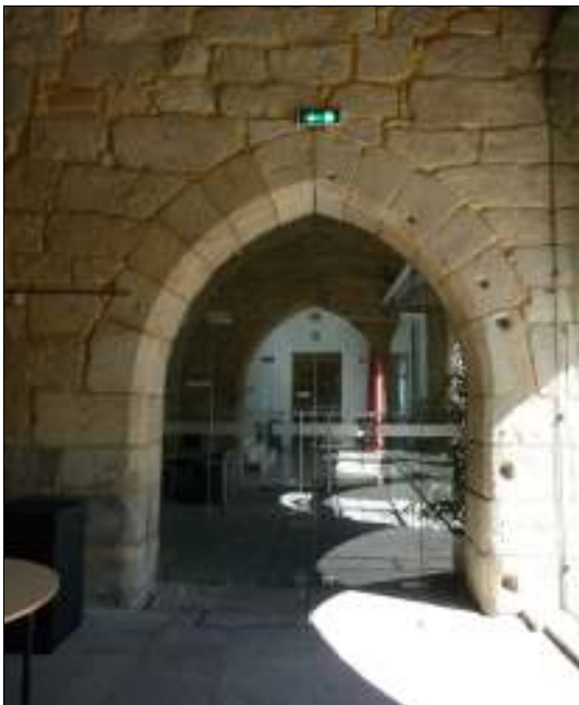
Fig. 8 - Arco quebrado de acesso ao corpo da torre
