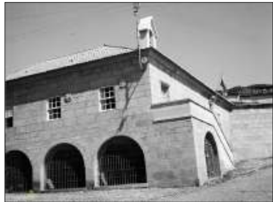
Fig. 72 - Casa da Câmara de Vila Flor
