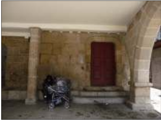
Fig. 50 - Porta de acesso à escada para o piso superior
