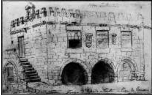
Fig. 71 - Casa da Câmara de Freixo-de-Espada-à-Cinta
