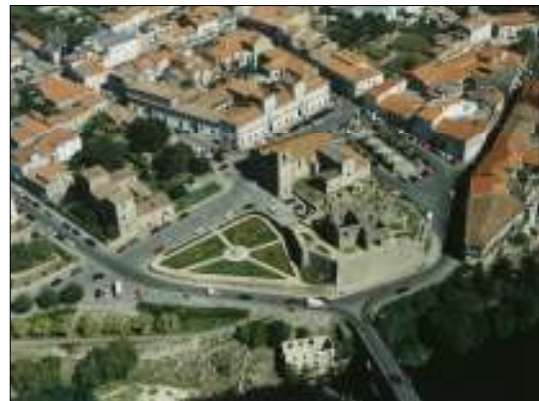
Fig. 15 - Vista aérea de Barcelos
