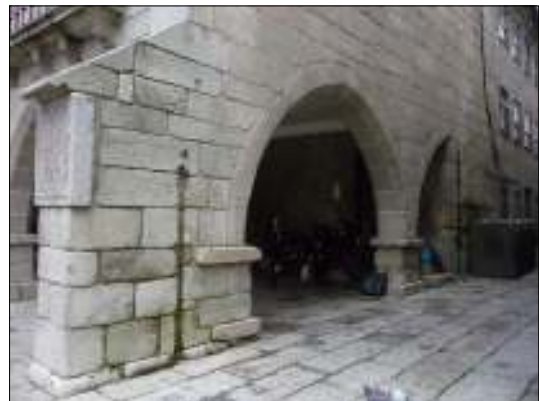
Fig. 49 - Vista parcial do alçado lateral nascente
